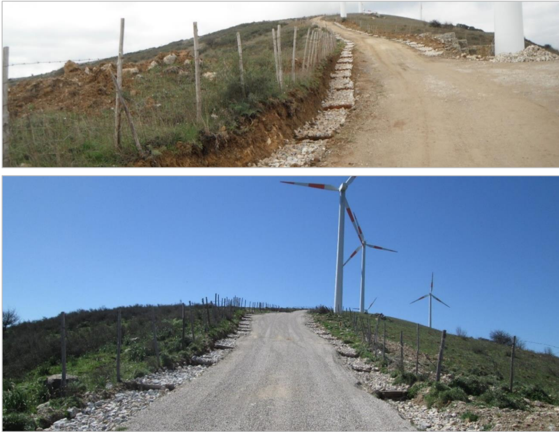
Figura 3.2 Esempi di sistemi di fossi di guardia con fondo rivestito in pietrame e salti.
