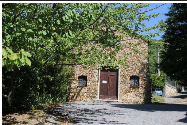
Vista della via S. Antonino (foto AmbienteItalia)
