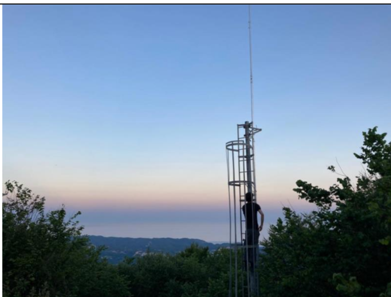
Zeno Porro mentre installa il palo di alluminio per le registrazioni in quota
