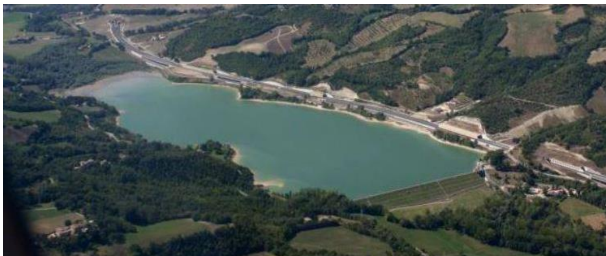
Figura 17: Serbatoio di Polverina - vista aerea
