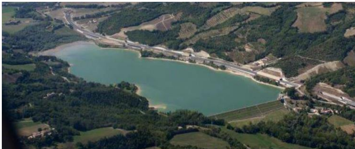
Figura 25: Serbatoio di Polverina - vista aerea
