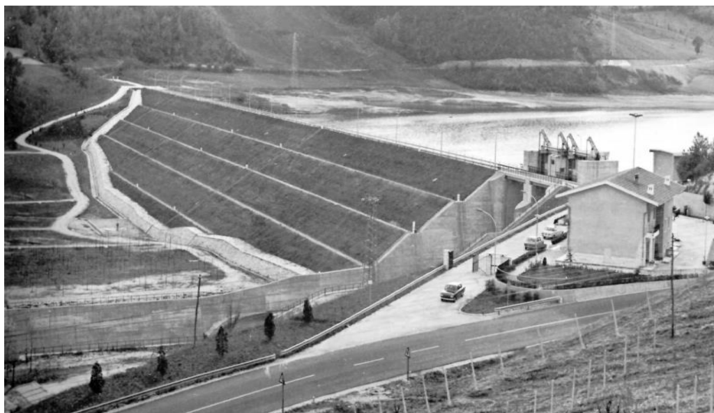
Figura 7: Diga di Polverina - vista da valle
