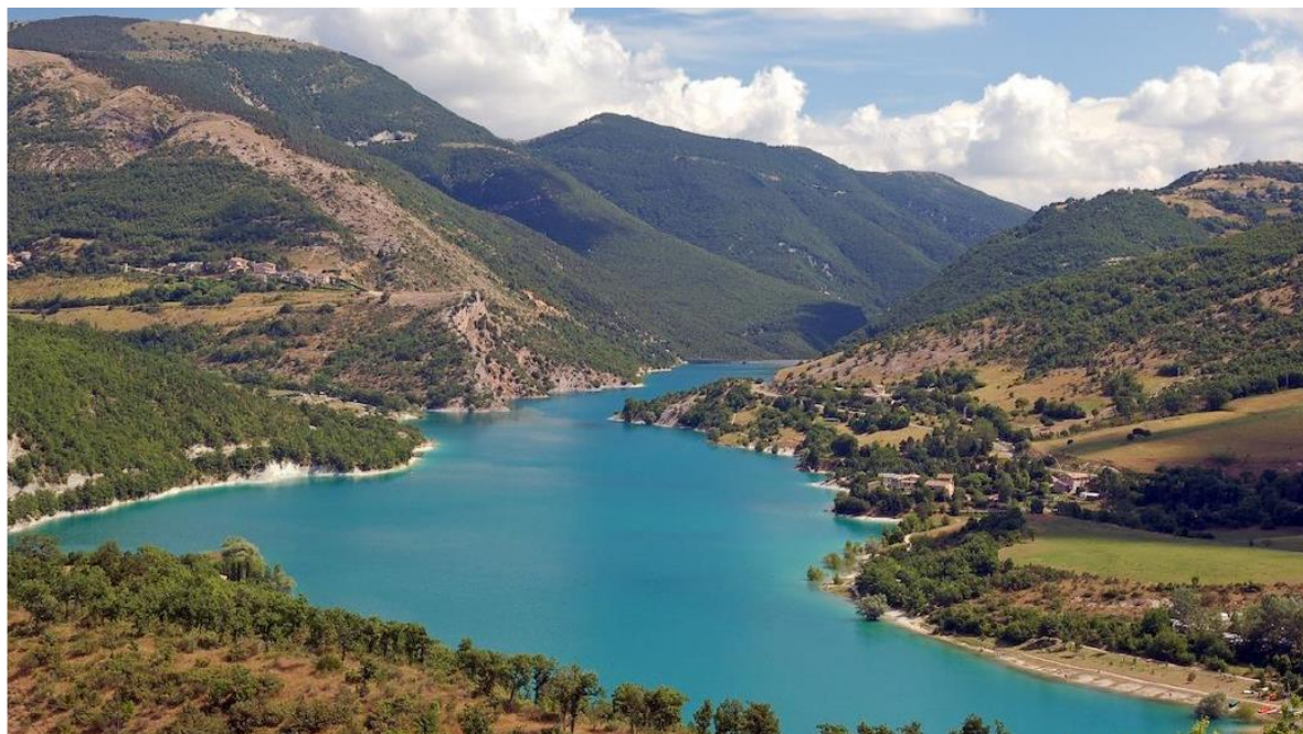
Figura 15: Serbatoio del Fiastrone – vista aerea
