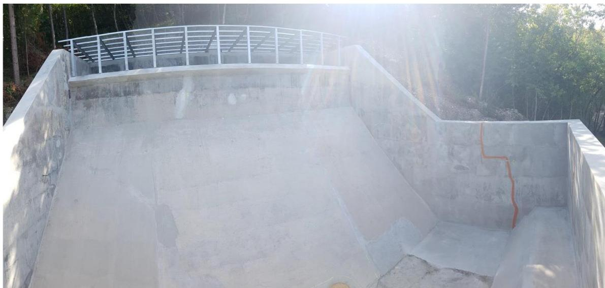
**Figura 11:** Der. Fiastrone – Pozzo Piezometrico – camera di espansione superiore
