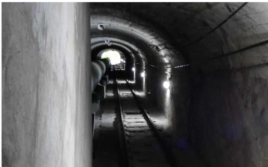
**Figura 15:** Der. Fiastrone - Condotta Forzata e piano inclinato - tratto in sotterraneo - vista verso monte
