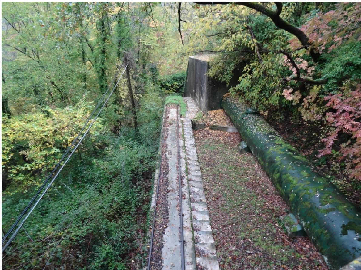
**Figura 14:** Der. Fiastrone - Condotta Forzata e piano inclinato - vista verso valle ed imbocco tratto in sotterraneo
