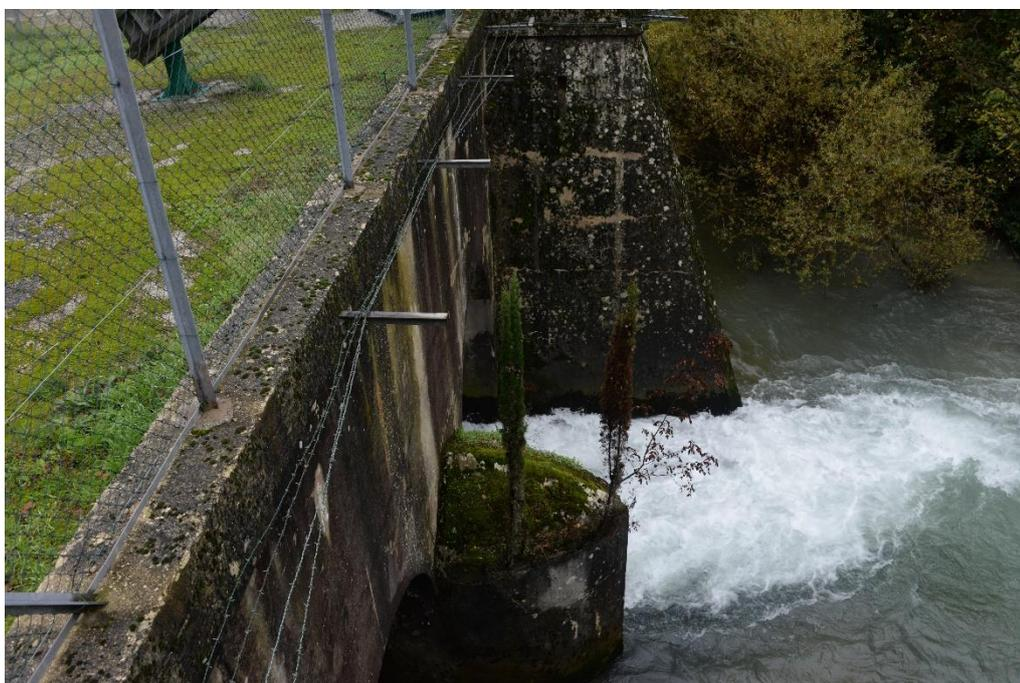
**Figura 30:** C.le Valcimarra - esterni - canali di scarico Gr.1 e 2 – scarico nel Fiume Chienti
