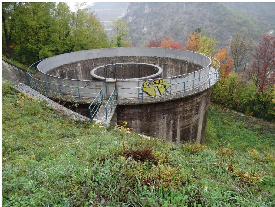
**Figura 18:** Der. Polverina – vasca di espansione del pozzo piezometrico
