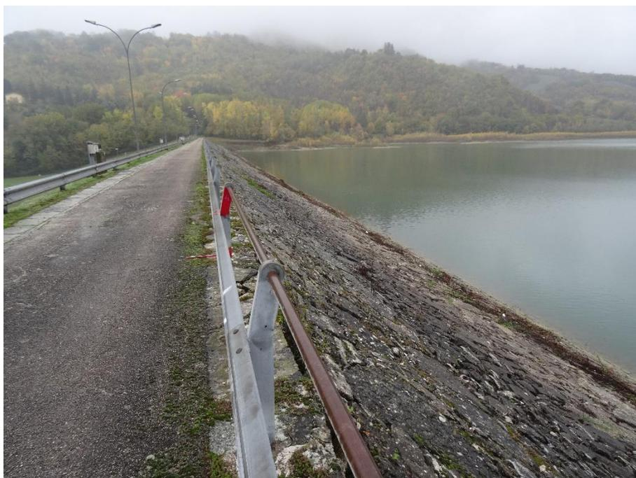
**Figura 6:** Diga di Polverina – piano di coronamento e paramento di monte
