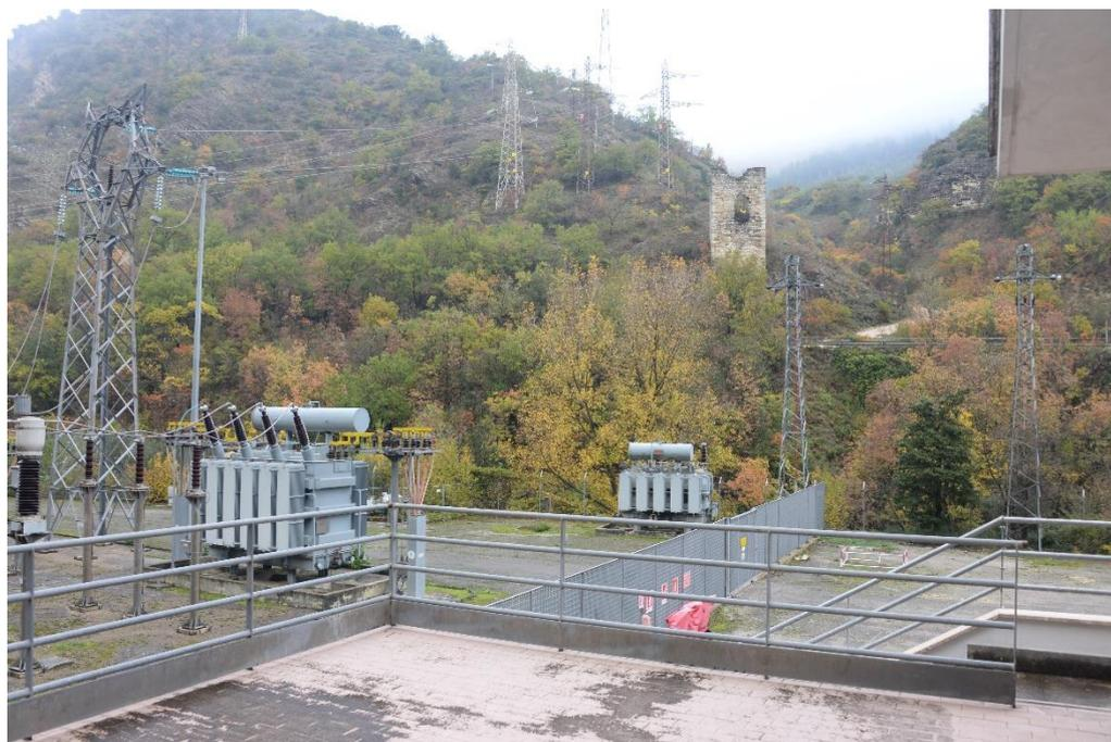
**Figura 35:** C.le Valcimarra - esterni – sottostazione elettrica – vista su TR1 e trasformatore di scorta
