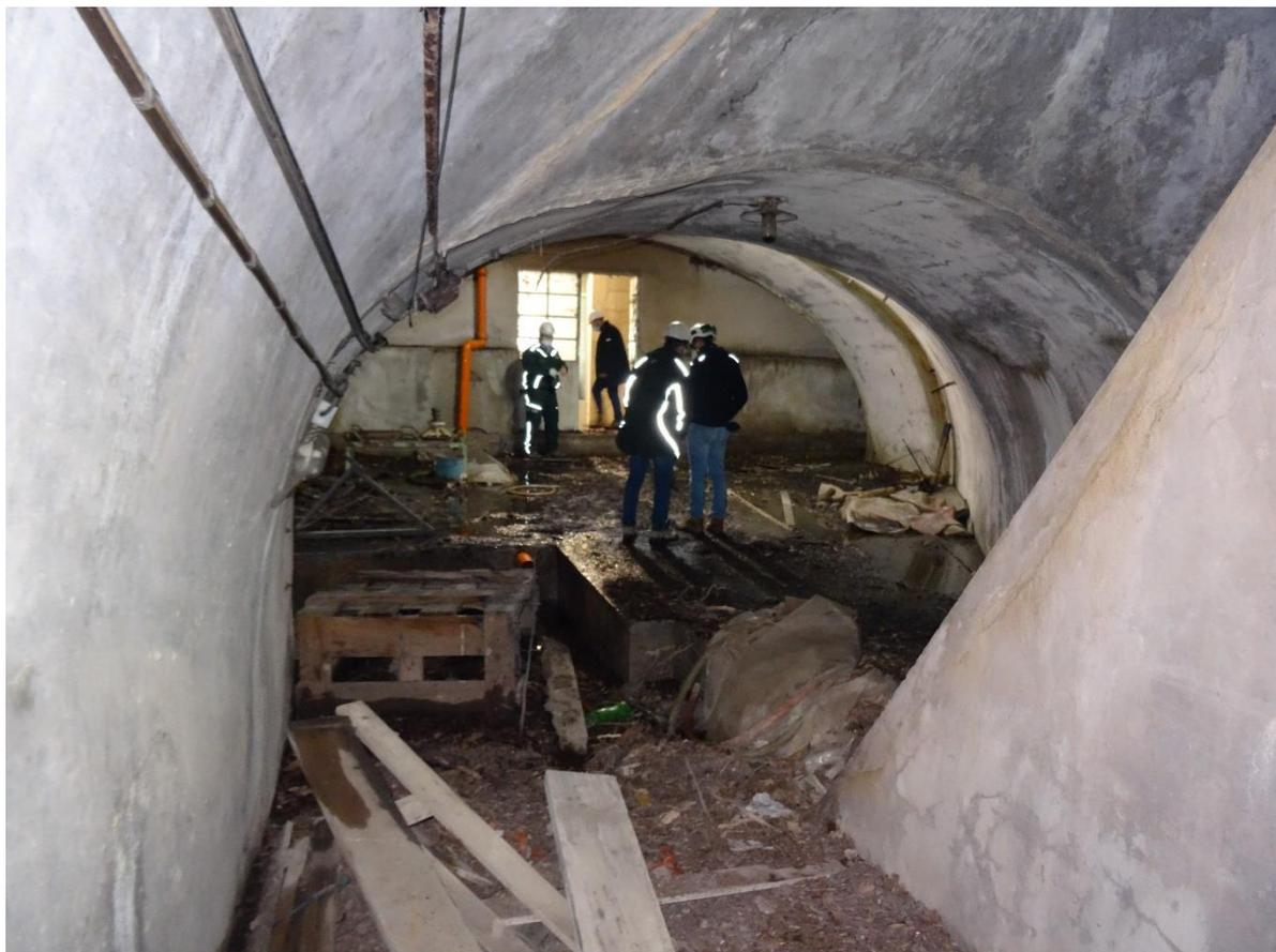
**Figura 16:** Der. Fiastrone - Condotta Forzata e piano inclinato - tratto in sotterraneo – biforcazione ed ingresso in centrale
