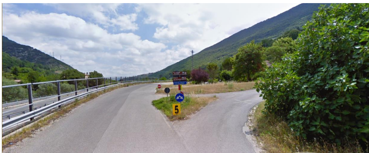
Figura 7: Accesso cantieri in quota – Svincolo verso Madonna del Sasso
