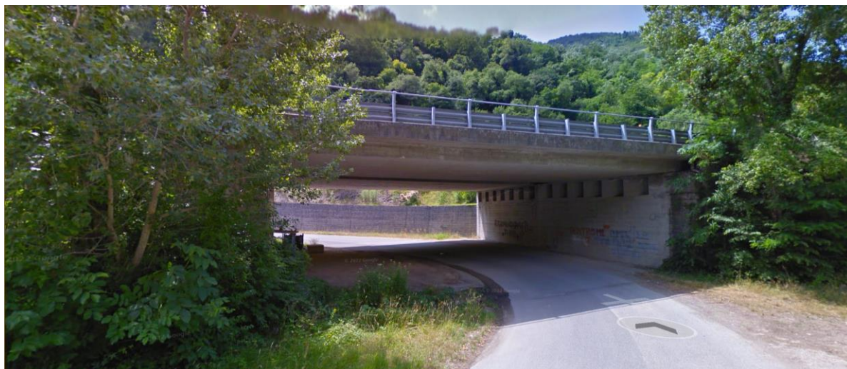
Figura 6: Accesso cantieri in quota – sottopasso S77var
