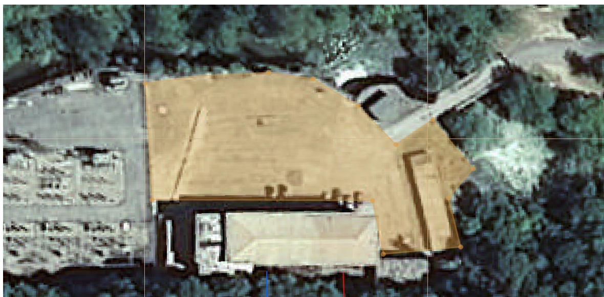
Figura 13: Cantiere principale: area logistica
