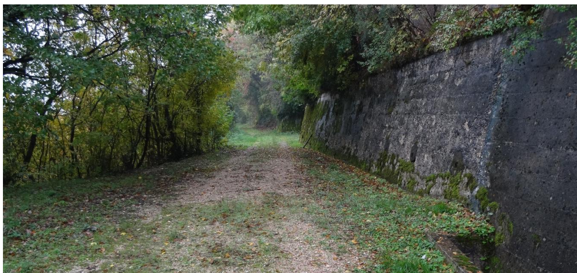
Figura 10: Accesso cantieri in quota – Strada di accesso alla camera valvole Polverina
