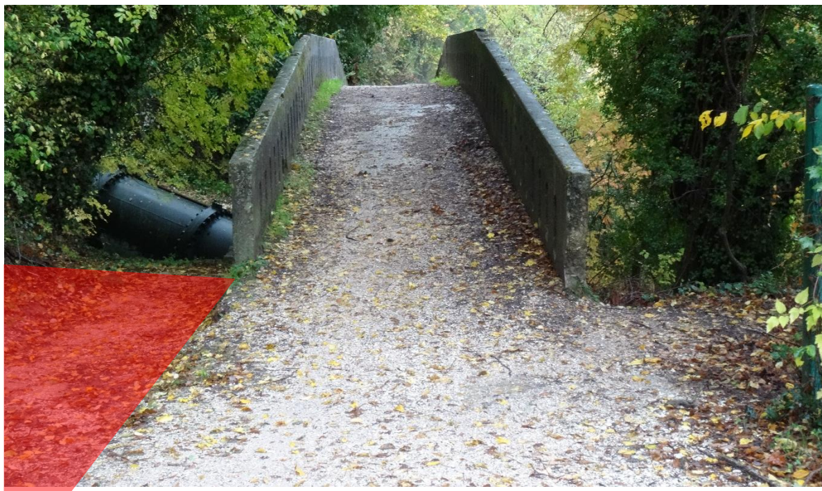
Figura 11: Accesso cantieri in quota – Area di Lavoro nuova camera valvole Fiastrone
