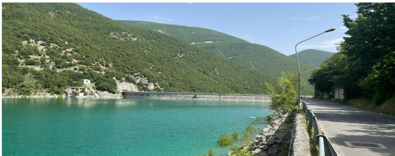
Figura 6: Vista da monte (lato destro orografico) della diga del Fiastrone e del serbatoio del Fiastrone (27 giugno 2022: quota del pelo libero 635,65 m s.l.m.)
