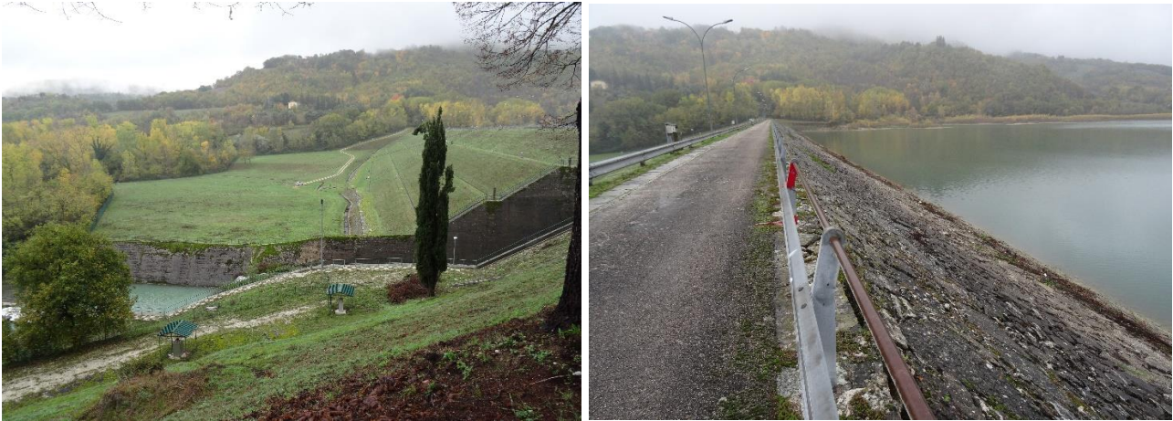
Figura 10: Invaso di Polverina, 9 novembre 2021. Da sinistra: vista del paramento di valle, con rivestimento in terreno vegetale; vista del paramento di monte, rivestito con una scogliera in pietrame calcareo. È visibile il piano di coronamento della diga, protetto da una struttura bituminosa (foto: Lombardi SA)
