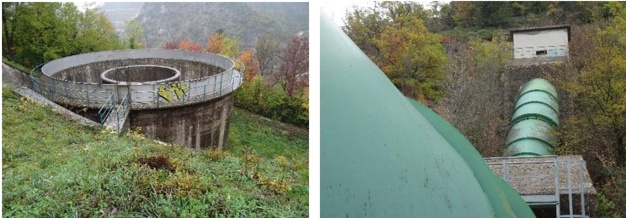
Figura 11: Derivazione Polverina: Pozzo piezometrico e Camera Valvole: disegno in sezione e foto relative al pozzo piezometrico, sopra, e alla camera valvole e condotta forzata all'aperto (foto 9 novembre 2022: Lombardi SA)
