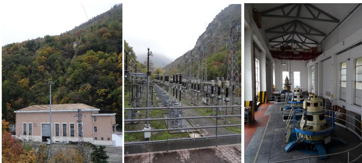
Figura 9: La centrale idroelettrica di Valcimarra. Nella foto a destra sono visibili i tre gruppi turbina Francis-alternatore ad asse verticale Gr. 1 e Gr. 2 alimentati dalle acque del Fiastrone e Gr. 3 alimentato dalle acque del Polverina
