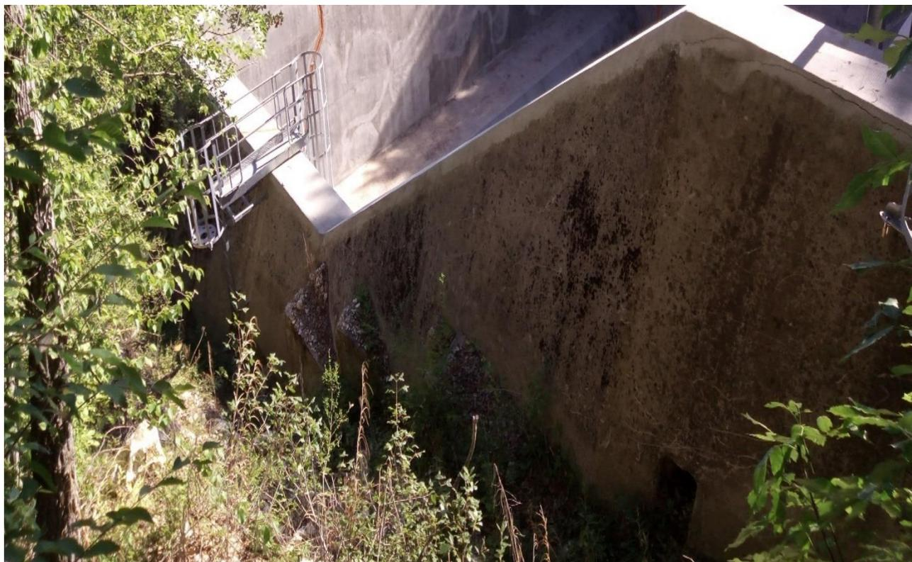
**Figura 93:** vasca di espansione da demolire
