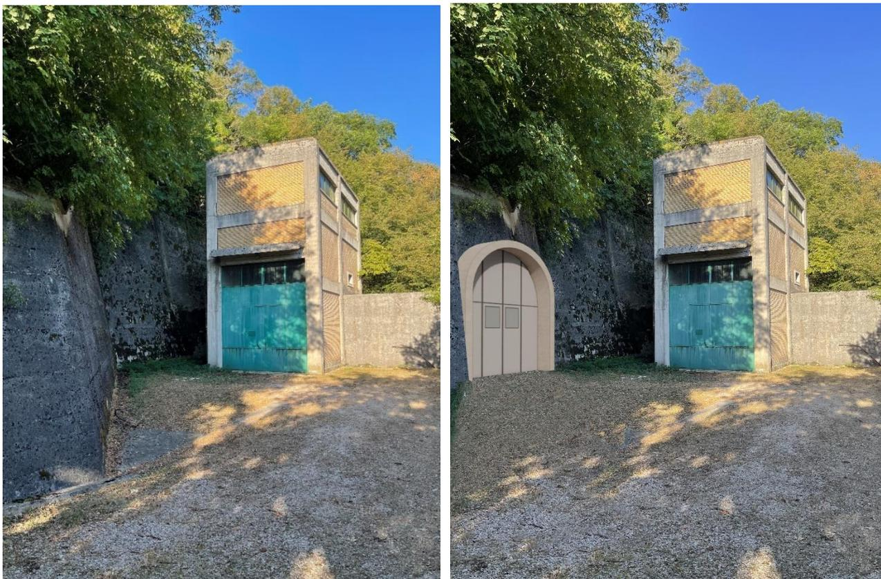
**Figura 102:** stato di fatto e fotosimulazione portale per ampliamento camera valvole Polverina
