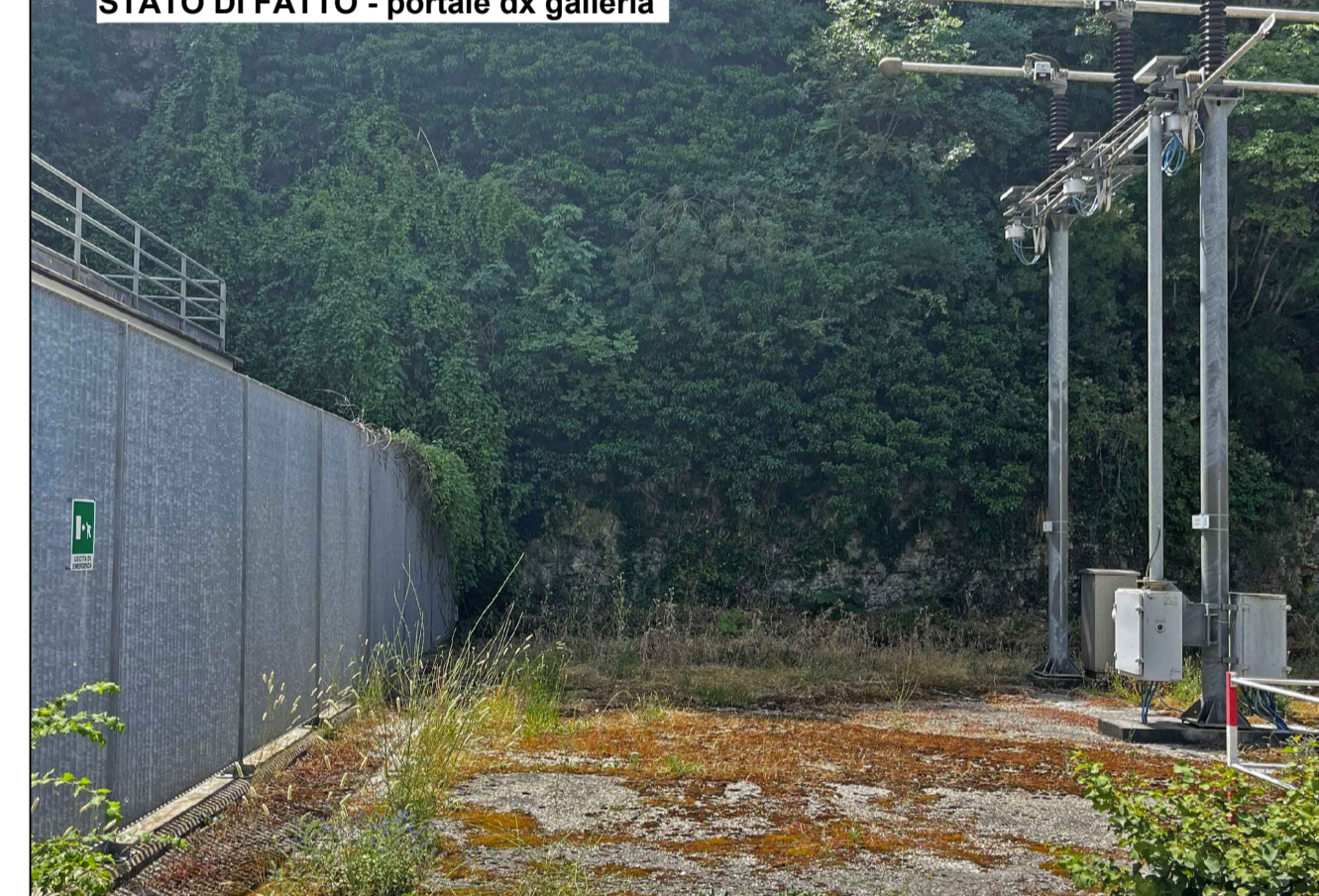
STATO DI FATTO - portale dx galleria
