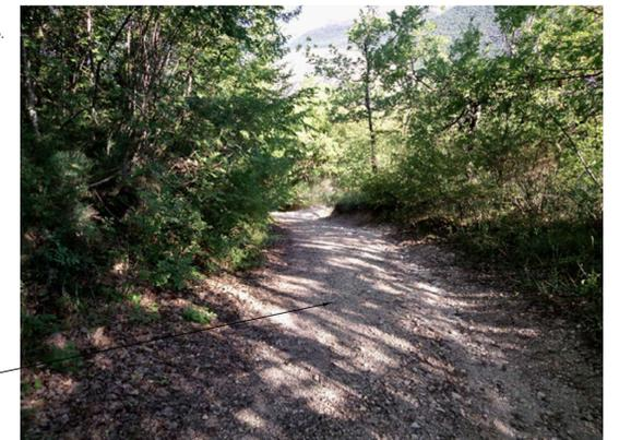
Esempio strada esistente con fondo naturale. Il fondo appare irregolare con rami laterali che riducono localmente la sezione utile
