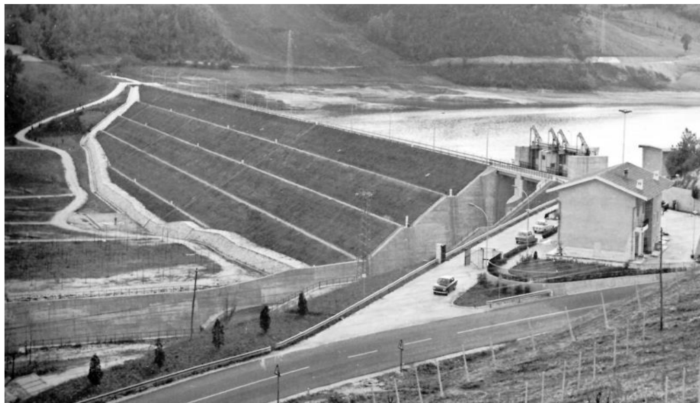
Figura 22: Diga di Polverina – vista da valle
