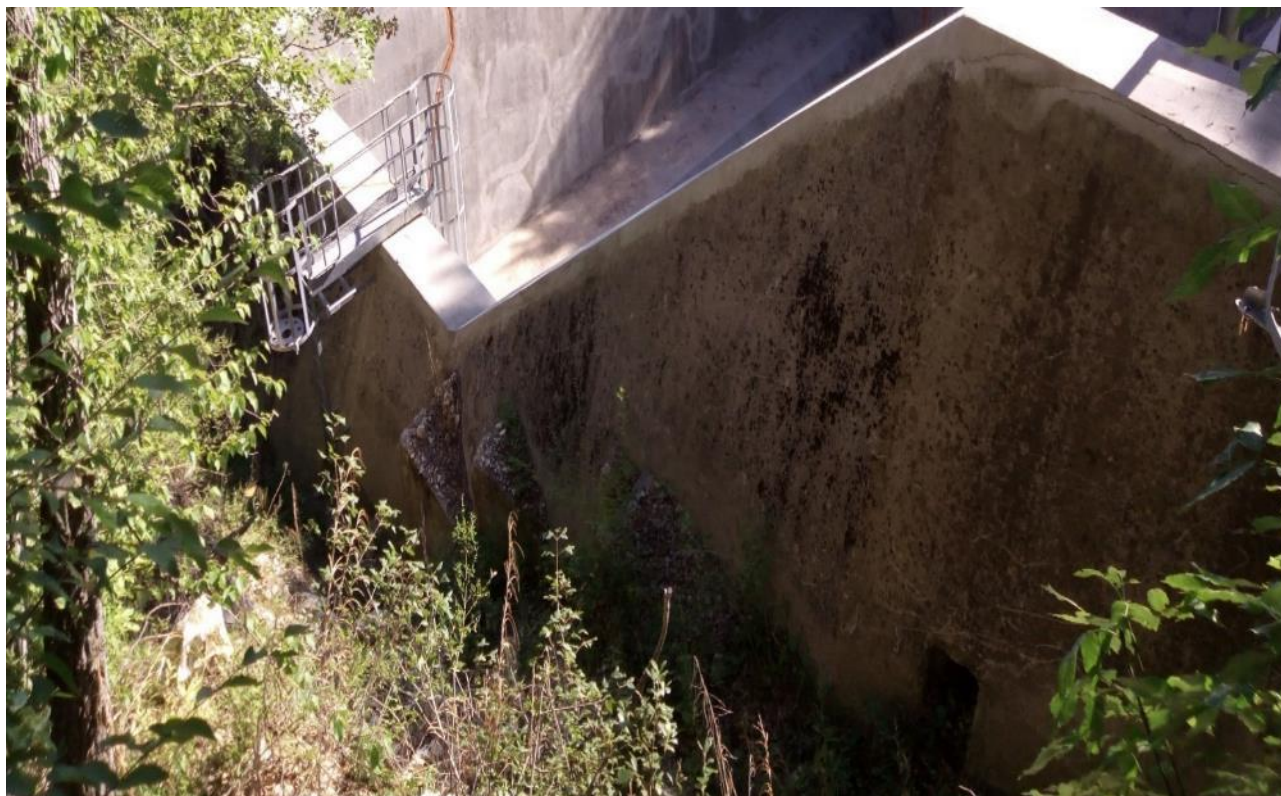
Figura 36: Vasca di espansione da demolizione
