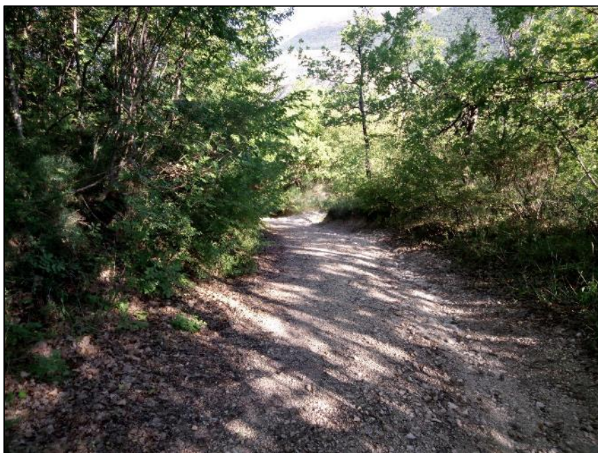
Figura 28: Esempio strada esistente con fondo naturale. Il fondo appare irregolare con rami laterali che riducono localmente la sezione utile
