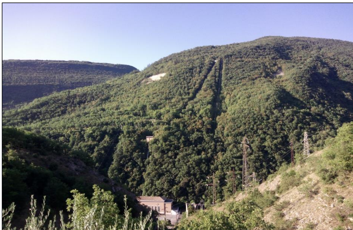
Figura 3: Vista del versante del Monte Fiungo oggetto di intervento
