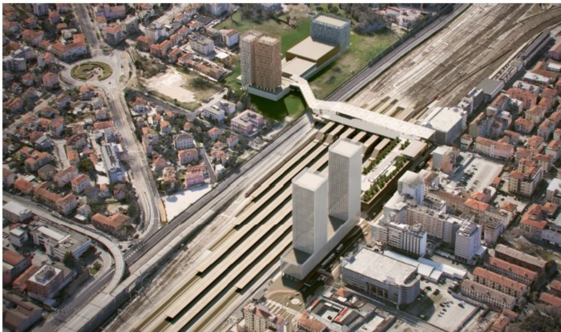
Fig. 2 –Nuova stazione di Venezia Mestre (Fonte: Lista di Controllo)
