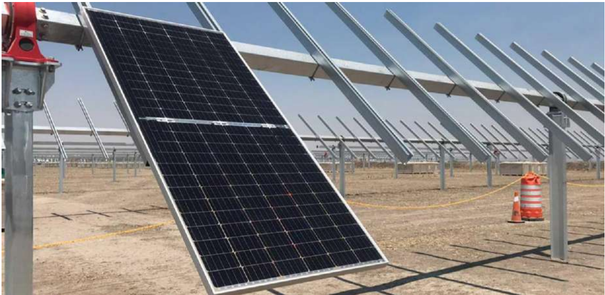
Figura 74 – Montaggio strutture (tracker)
