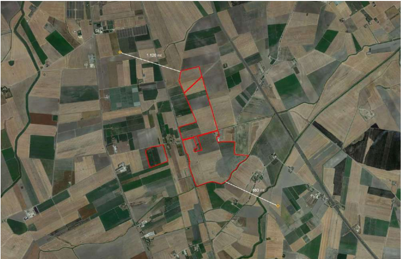
Figura 85 - Inquadramento degli impianti eolici realizzati limitrofi all'area del FV
