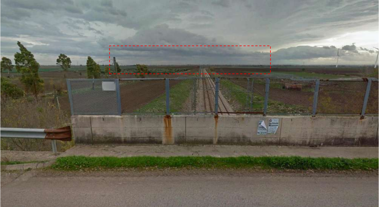
Figura 19 – Vista attuale dal tratto ferroviario Foggia-San Severo
