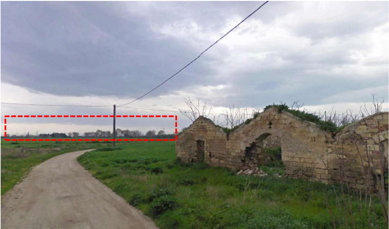
Figura 10 – Punto di presa da Masseria Cantone
