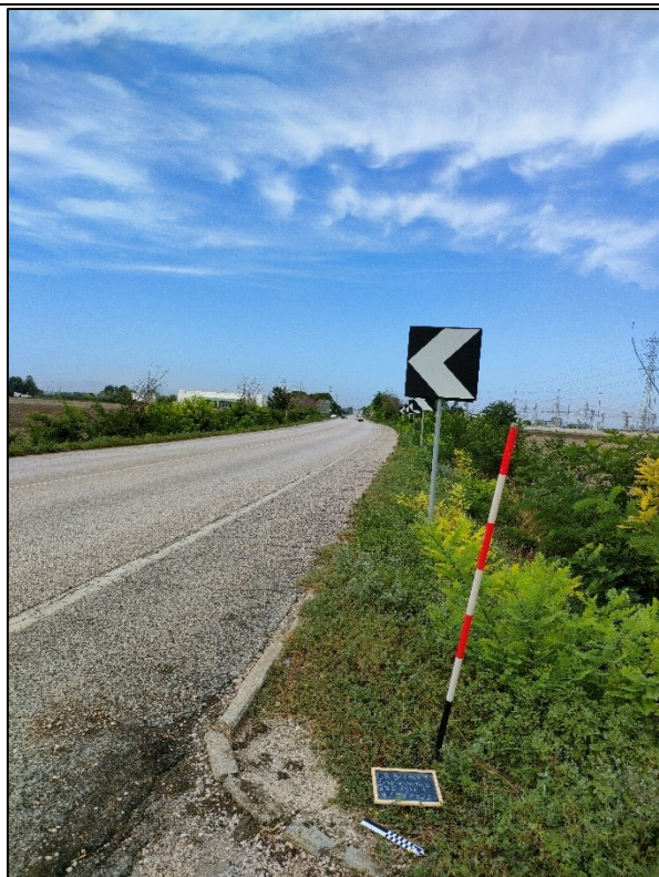
Presso Stazione Elettrica ed SSU
