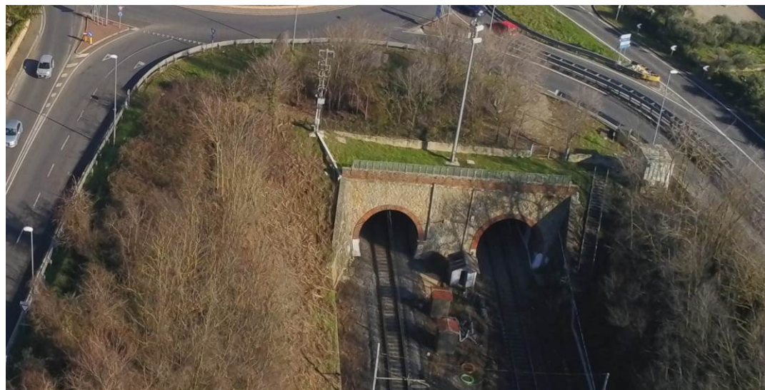
Figura 4.26 – Veduta a volo di uccello dell'imbocco ovest della galleria ferroviaria esistente
