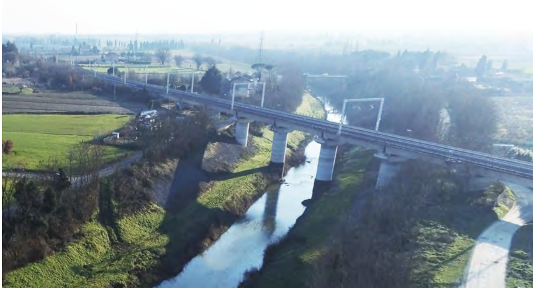
Figura 9.8 Immagine del sovrappasso esistente linea AV sul Canale Maestro della Chiana.
