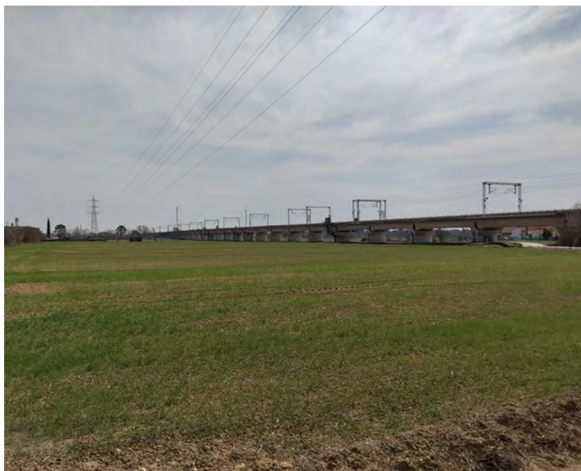
Figura 2.2 TRATTO II, vista della linea dell'alta velocità Roma-Firenze con campi di seminativo.
