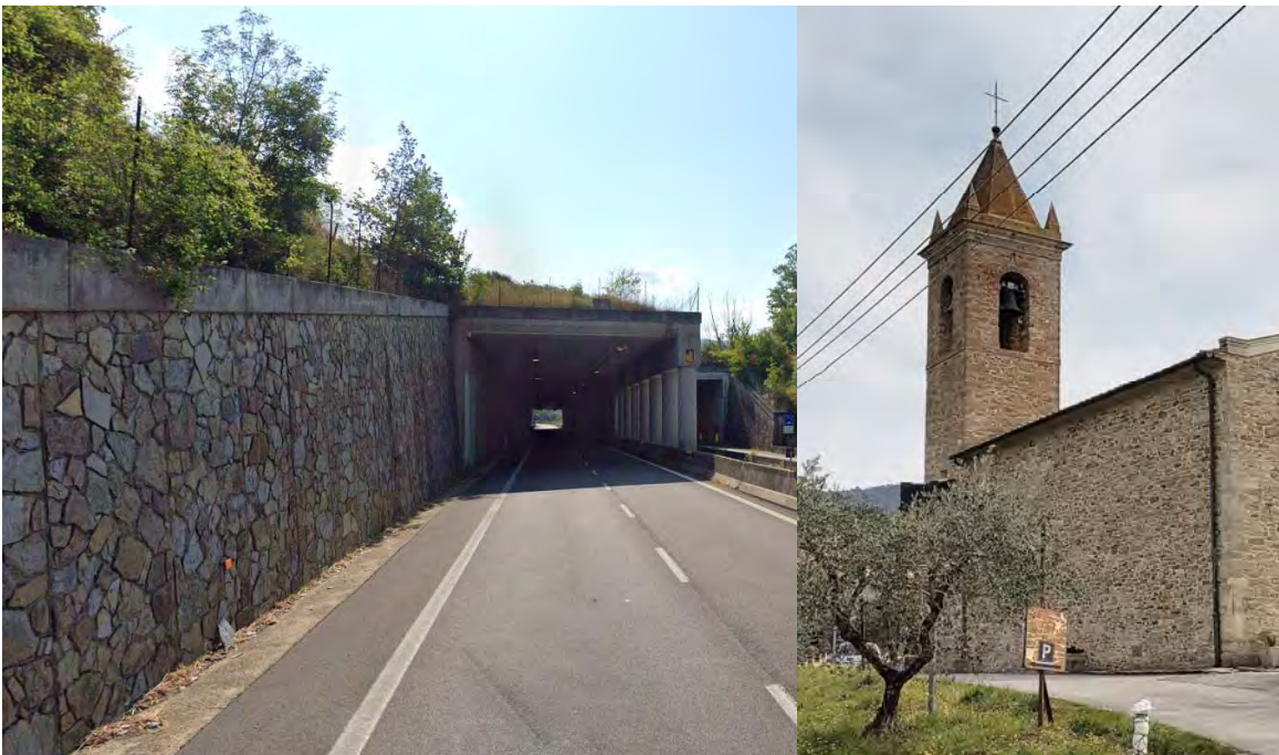
Figura 9.3 Rivestimenti esistenti SS73 in prossimità di galleria all'altezza di località Palazzo del Pero e immagine della Pieve di Santa Mustiola a Quarto.
