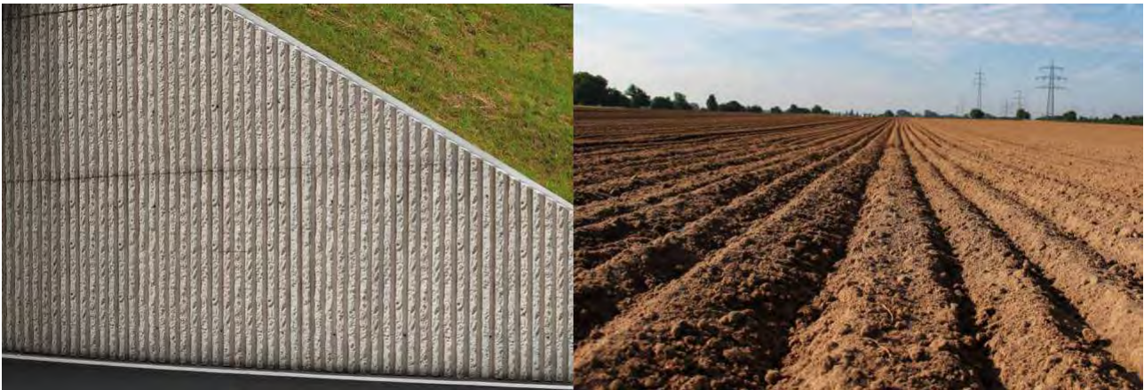
Figura 9.5 Muri in cemento facciavista trattati con matrici a motivo rigato a spacco irregolare.
