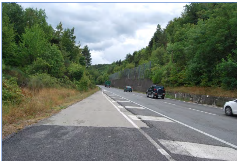
AR_34 Est. Viadotto Le Selve
