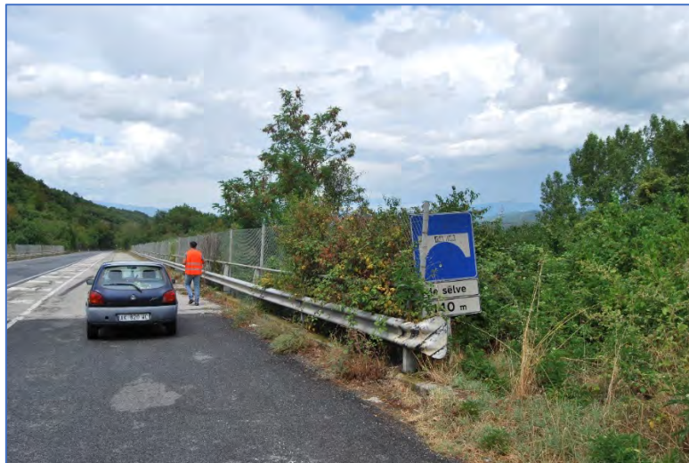
AR_34 Ovest. Viadotto Le Selve
