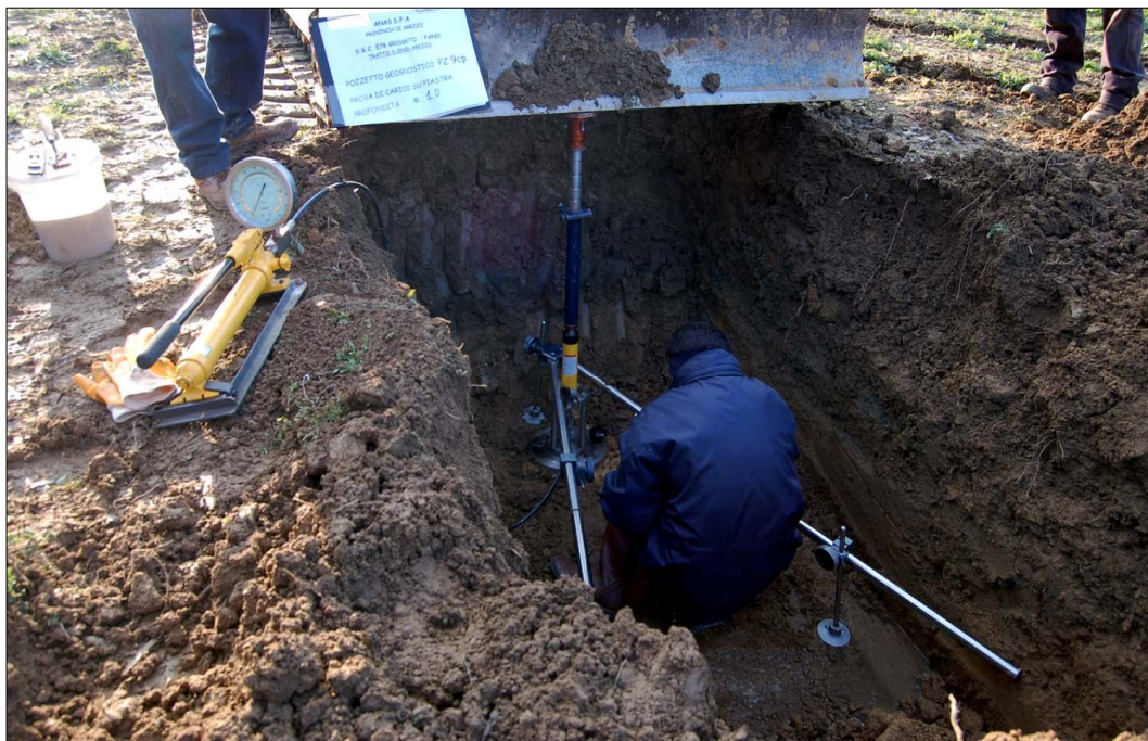
Foto 3 – prova di carico su piastra
