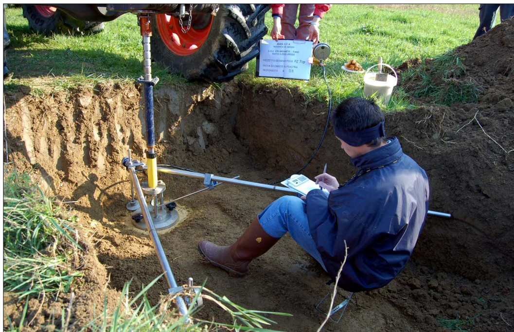
Foto 3 – prova di carico su piastra
