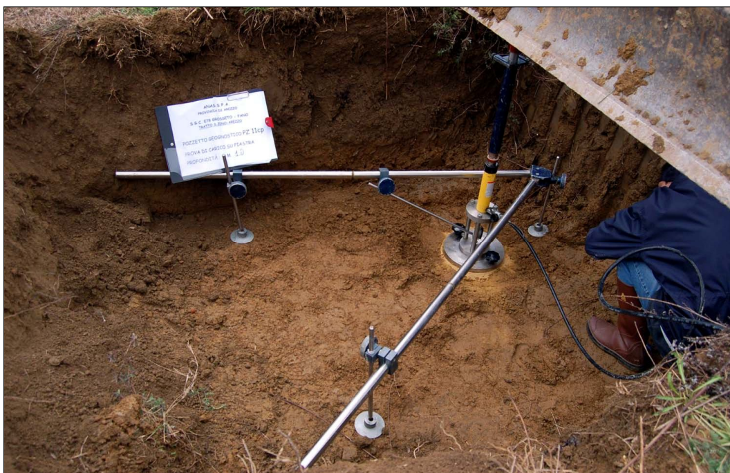
Foto 2 - prova di carico su piastra
