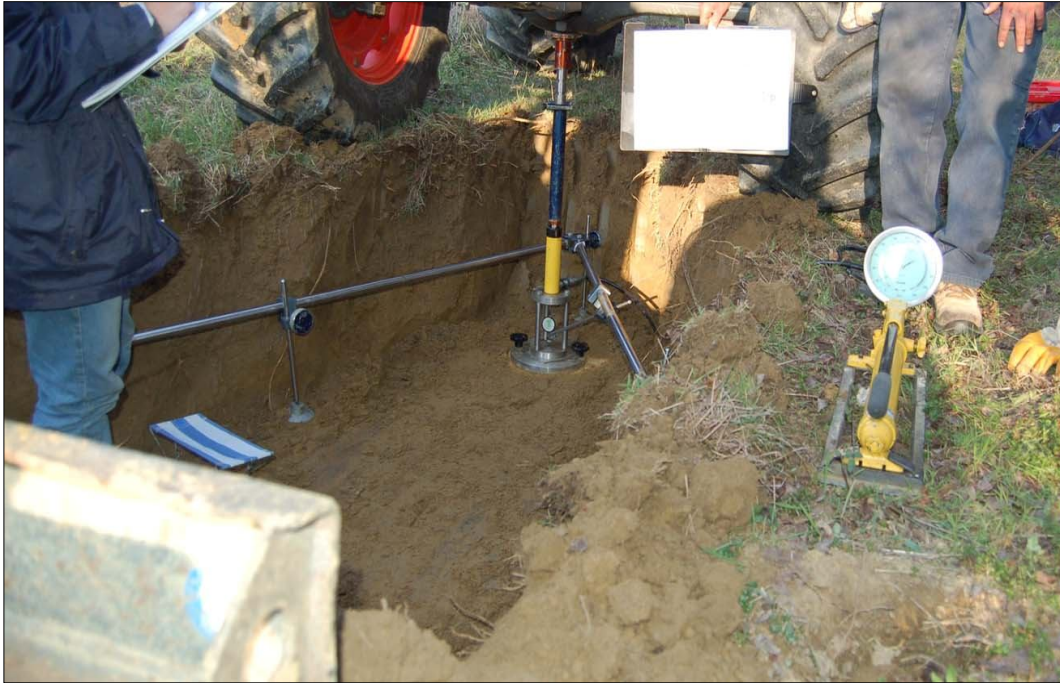
Foto 3 – prova di carico su piastra
