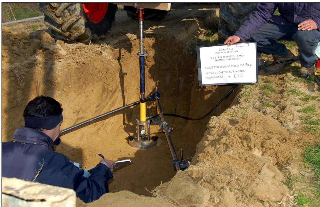
Foto 3 - prova di carico su piastra
