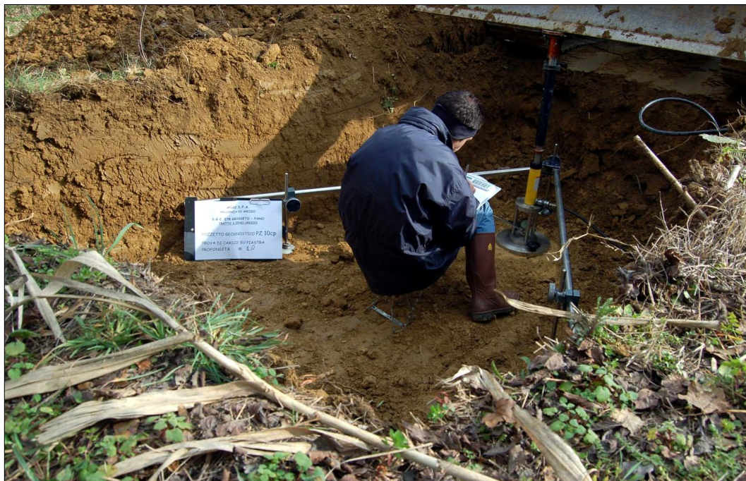
Foto 2 - prova di carico su piastra
