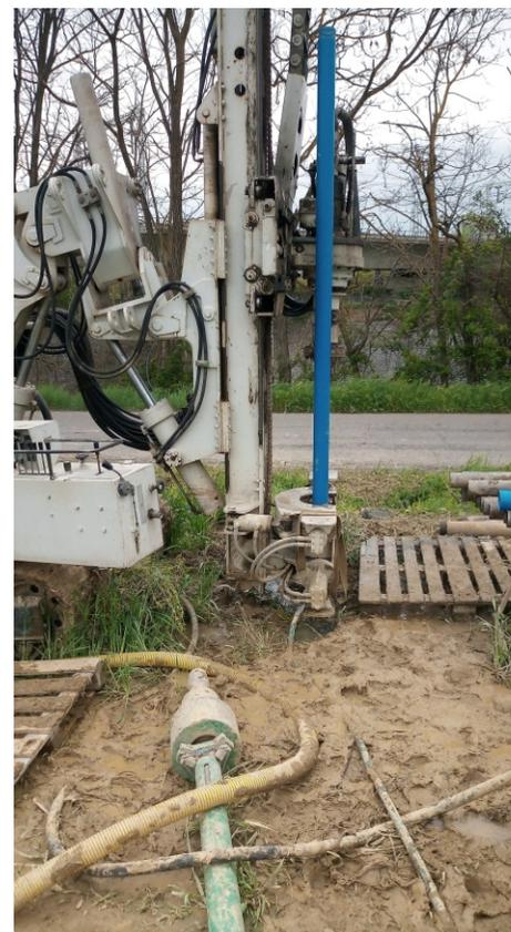
Installazione Tubo per prova geofisica
