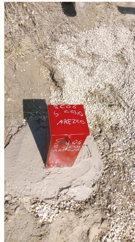
Pozzetto di protezione in ferro
