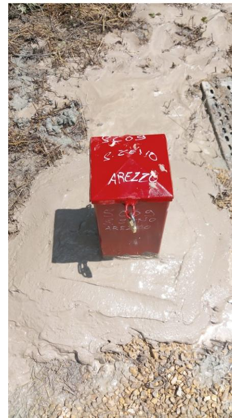
Pozzetto di protezione in ferro
