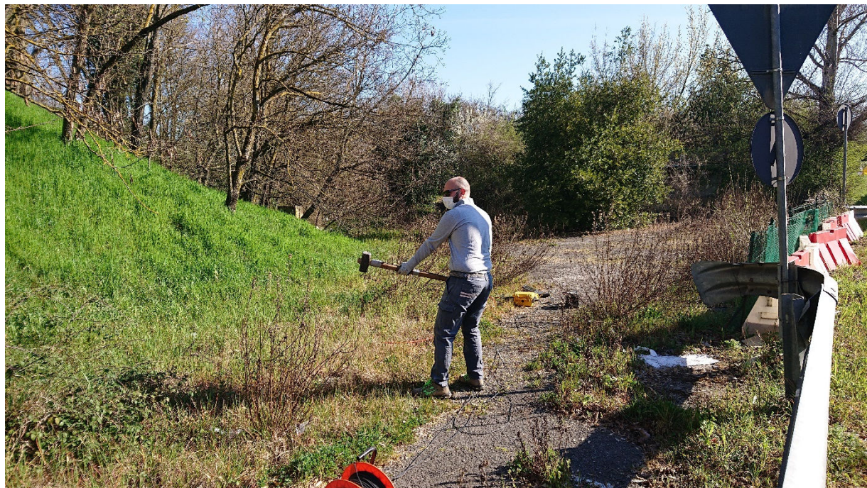
Esecuzione indagine sismica a rifrazione A_Sism03
