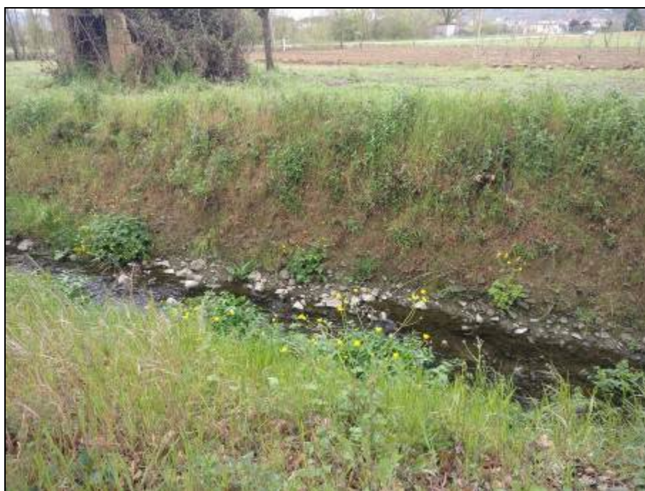
Foto 8-15: Fosso situato presso la pk. 1+200.
