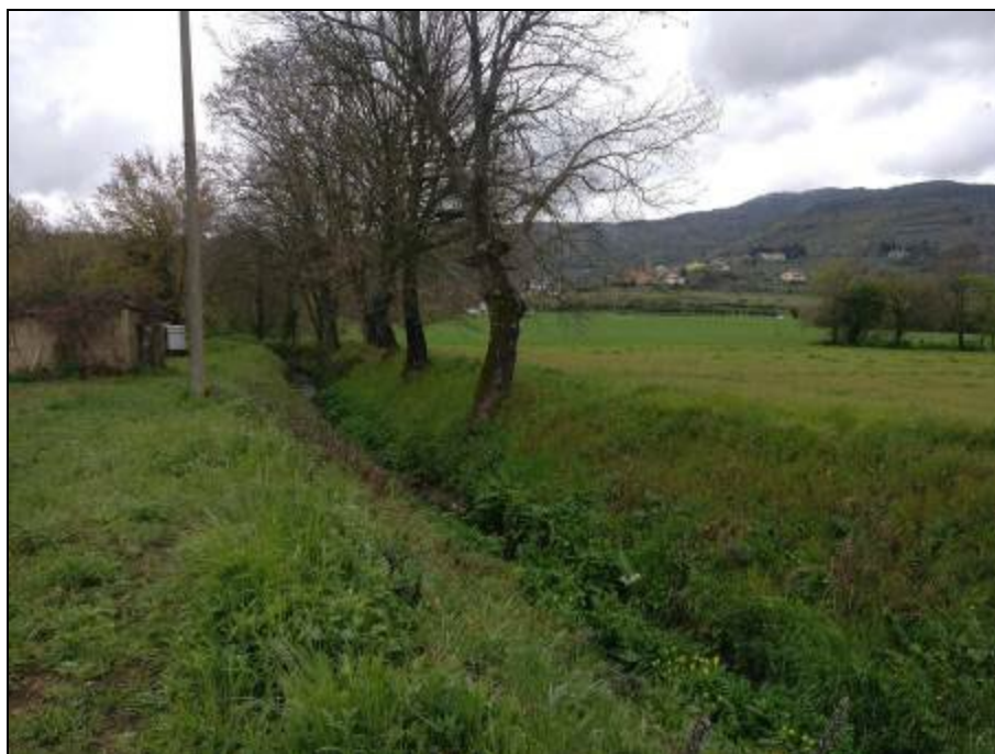
Foto 8-14: Fosso situato presso la pk. 1+000.
