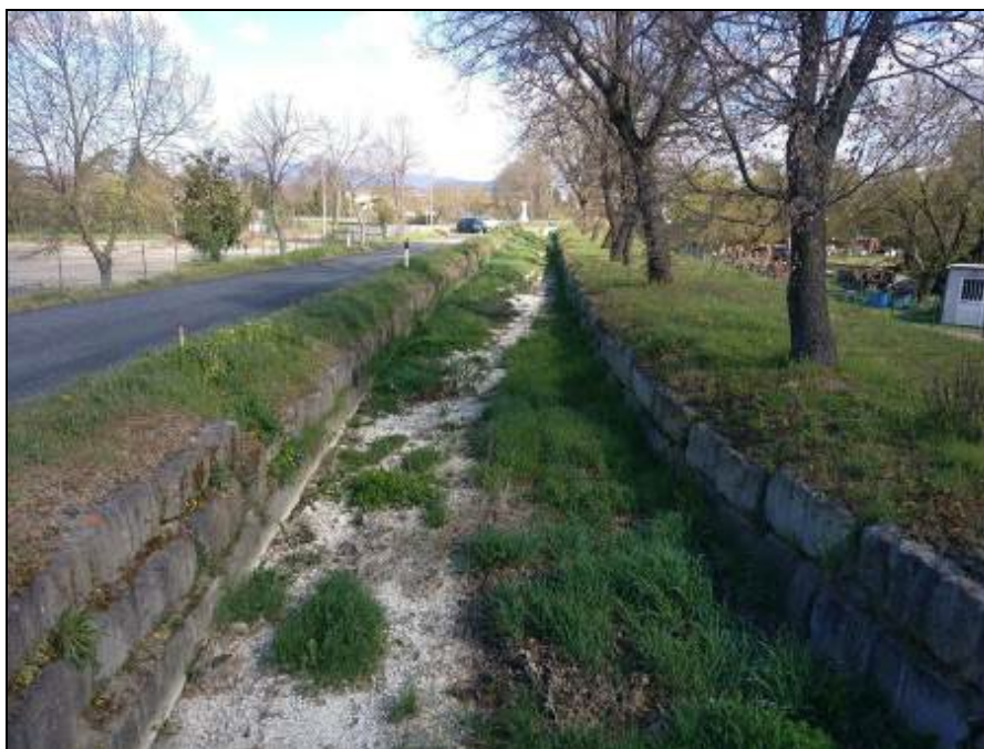
Foto 8-4: Alveo pensile del Canale Rio Fosso del Lupo, attraversato dal Ramo A presso la pk. 4+050 circa .
