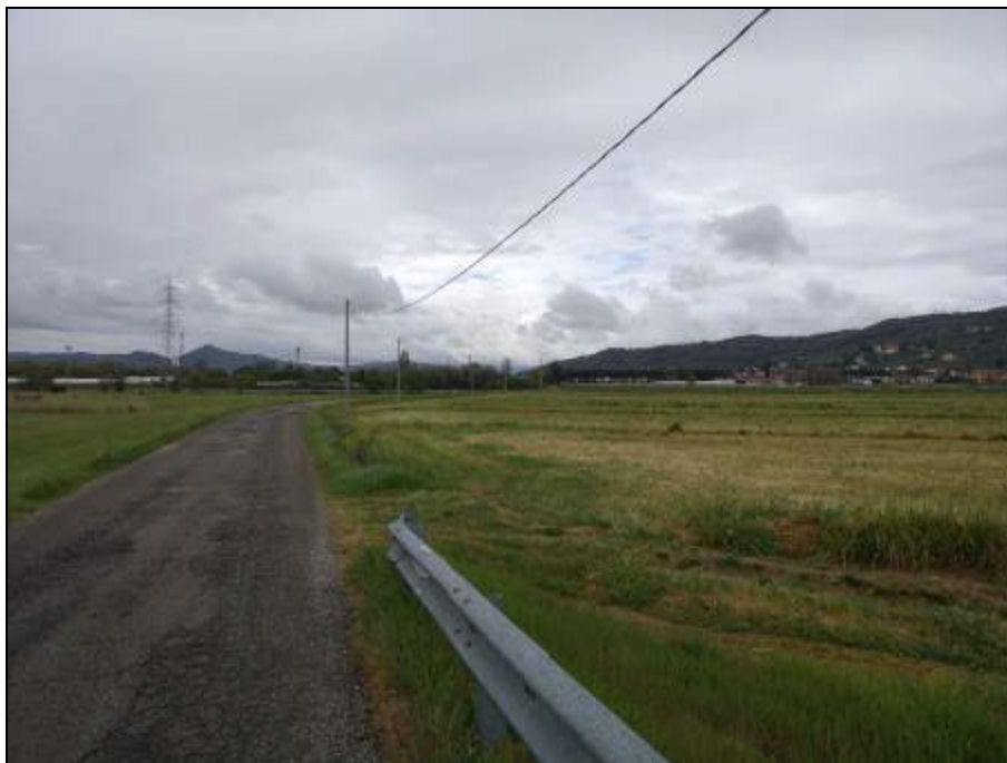
Foto 8-12: Panoramica del pianeggiante tratto compreso tra le pk. 0+000 e 0+300 (vista verso sud).
