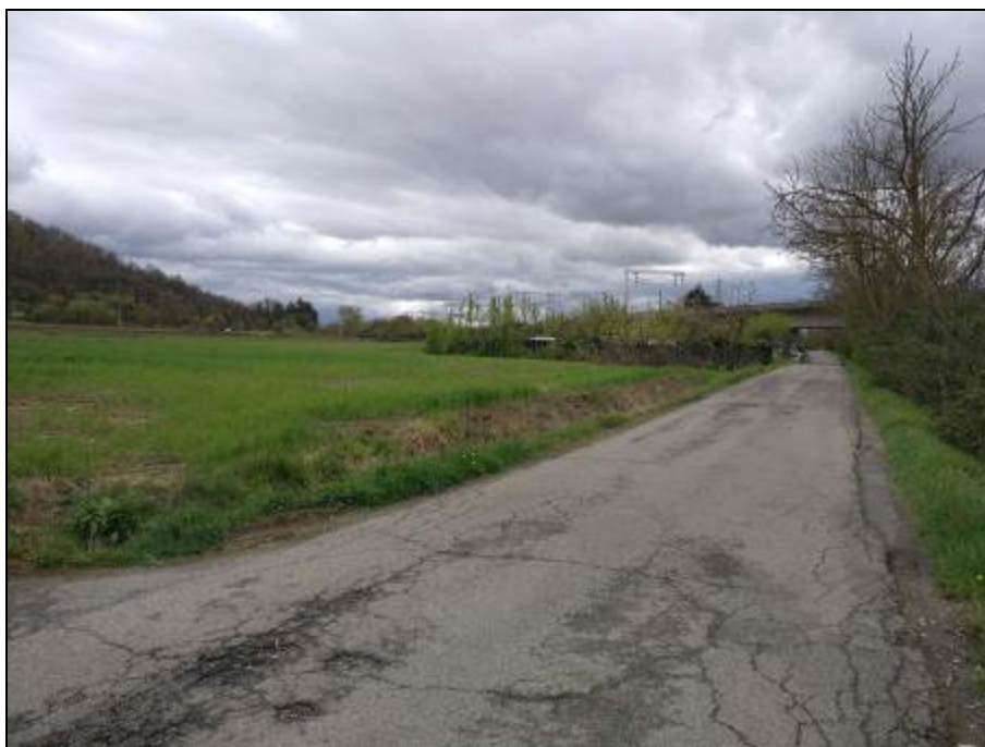
Foto 8-8: Panoramica del sub-pianeggiante tratto compreso tra le pk. 2+900 e 3+050 (vista verso sud).
