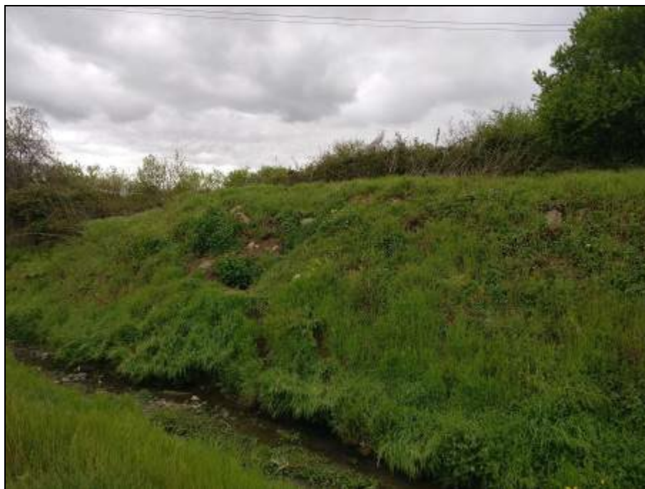
Foto 5-7: Riporti antropici di spessore considerevole ubicati in corrispondenza del tratto centrale del Ramo A..
