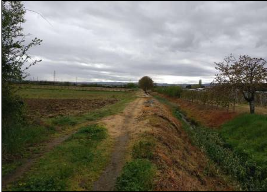
Foto 8-1: Territorio pianeggiante del tratto compreso tra le pk. 0+000 e 0+825.
