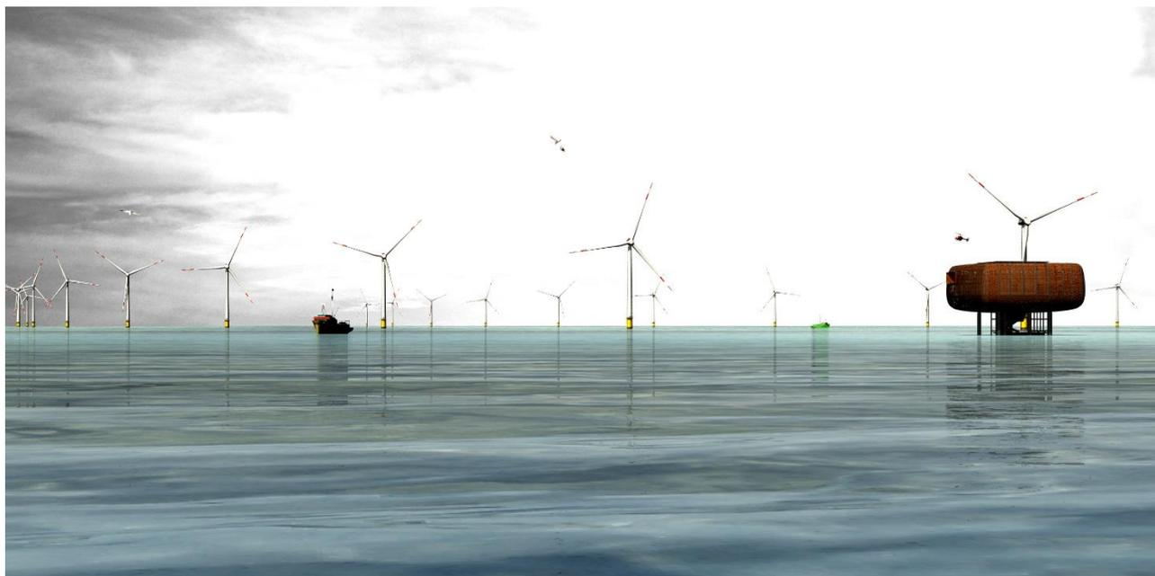
Oggetto della Relazione Generale è il progetto della Centrale eolica offshore "Rimini" ubicata nel mare antistante la costa tra Rimini e Cattolica, composta da 51 aerogeneratori della potenza di 6,45 MW (per 330 MW complessivi) e opere di collegamento alla RTN (Rete di Trasmissione Nazionale), con punto di connessione alla Stazione TERNA "San Martino in Venti" ubicata in comune di Rimini.
