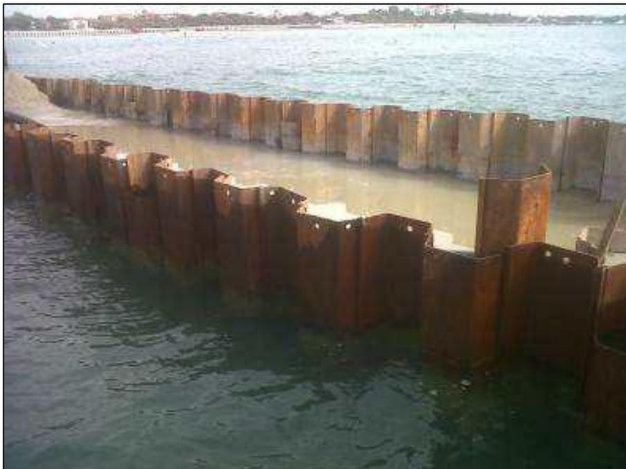
Figura 7.15 \_ Postazione di recupero con palancole per il contenimento il recupero dei fanghi di perforazione
