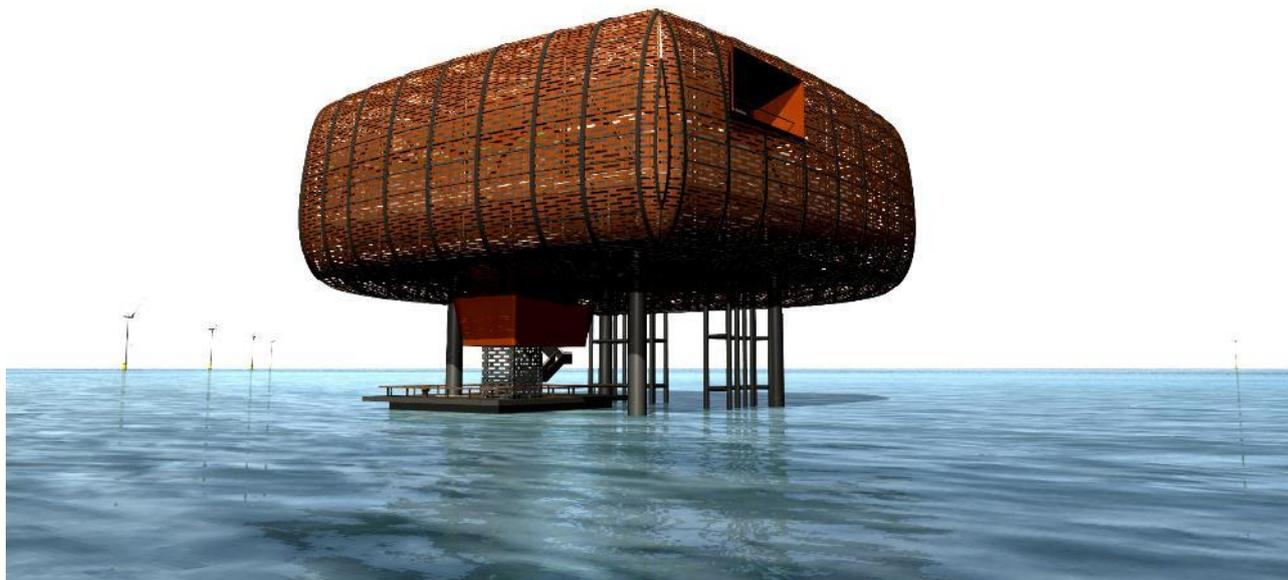
La stazione di trasformazione elettrica marina raccoglie i cavi provenienti dai vari sottocampi alla tensione di 66 kV e dopo la trasformazione del voltaggio a 380 kV invia l'energia ai cavi di collegamento con la costa, secondo lo schema unifilare riportato negli elaborati OWFRMN\_V2-SC4-03-1 e OWFRMN\_V2-SC4-03-2.
