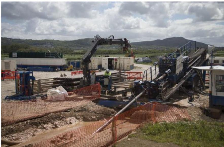
Figura 3.29 \_ Esempio di drilling rig per la realizzazione di HDD terra-mare (Burbo Bank) .
