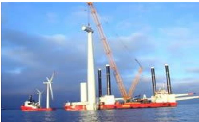
Figura 3.14 \_ Pontone durante l'assemblaggio di una navicella
