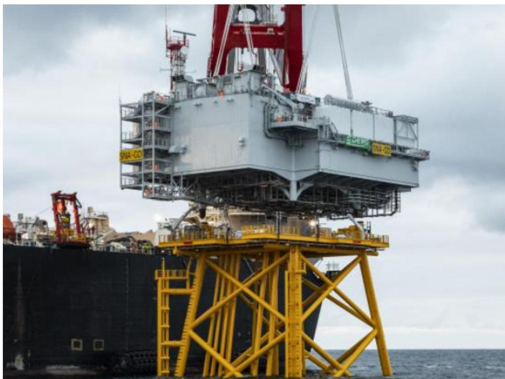
Figura 3.19 \_ Installazione Topside
