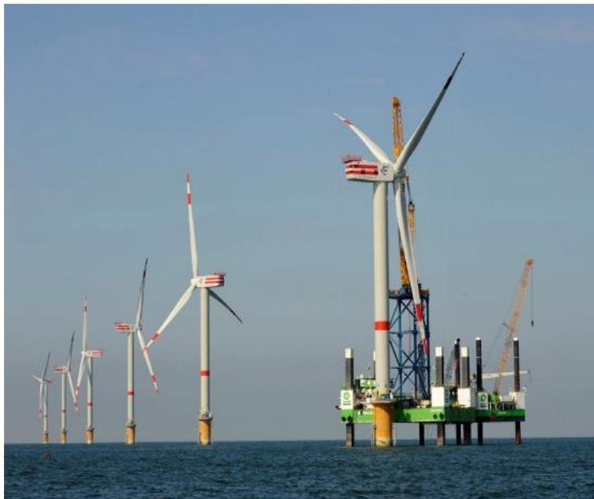
Figura 3.16 \_ Installazione pale del rotore su Aerogeneratore
