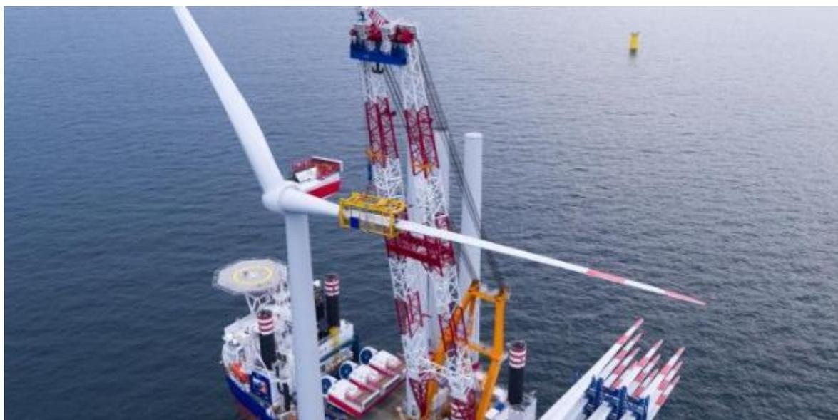
Figura 3.13 \_ Esempio di trasporto ed installazione componenti aerogeneratori (progetto Gemini, Van Oord)
