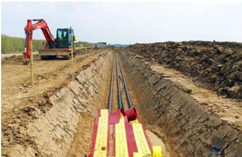
Figura 3.31 \_ Esempio di scavo per interrimento cavo (Hornsea Project One) in campagna.
