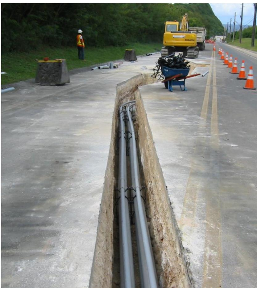
Figura 3.32 \_ Esempio di scavo per interrimento su asfalto .
