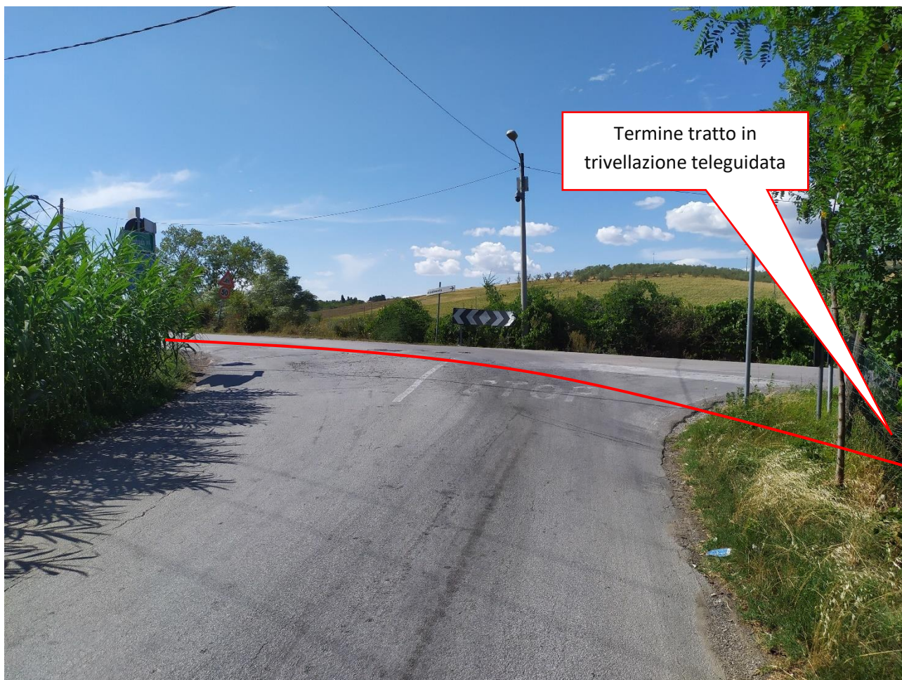
Figura 3.17 – Fine tratto in trivellazione teleguidata ed ingresso su Via Santa Aquilina
