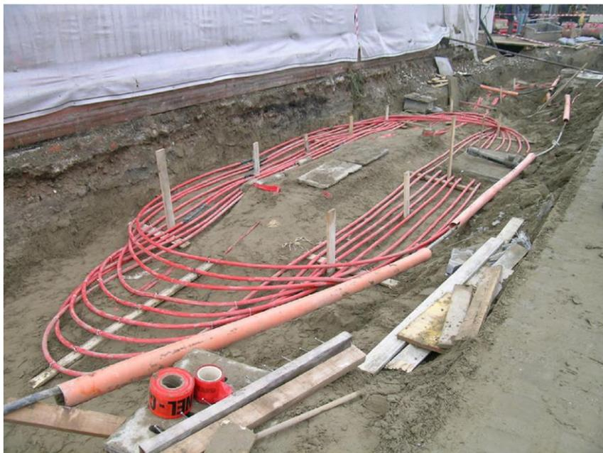
Figura 6.6 \_esempio di installazione di loop passivi in corrispondenza della buca giunti
