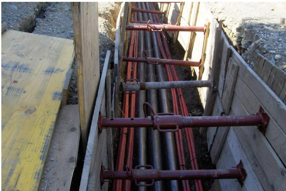
Figura 6.8 \_ esempio di installazione di loop passivi in corrispondenza dei cavi AT
