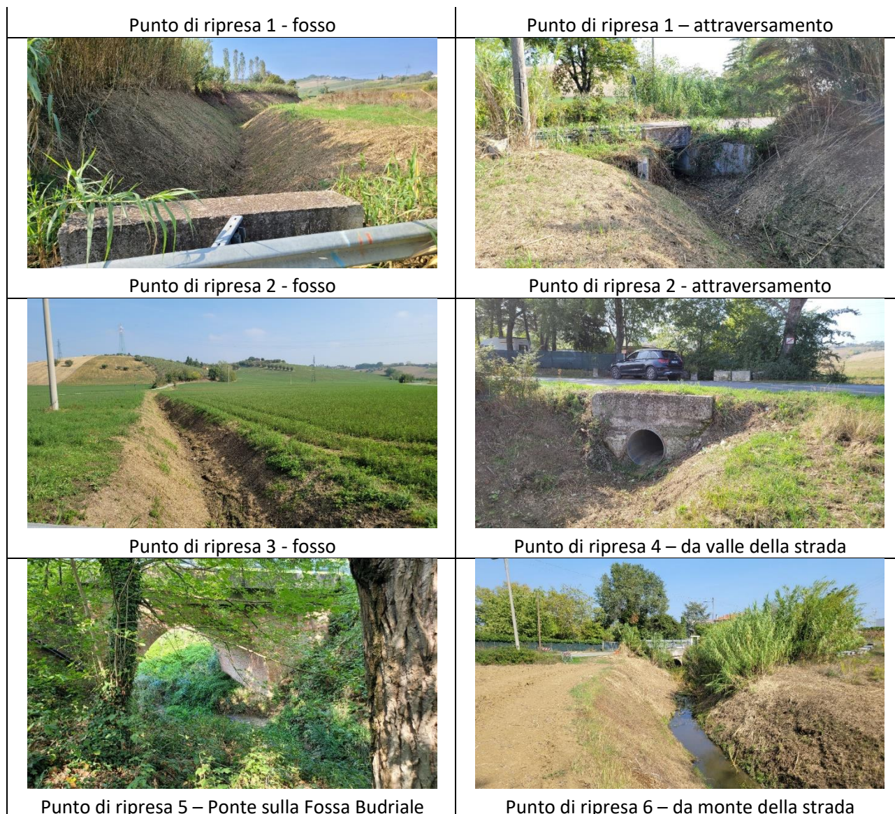
Figura 2.6 – Ripresa fotografica di alcuni corsi d’acqua della zona di intervento.
