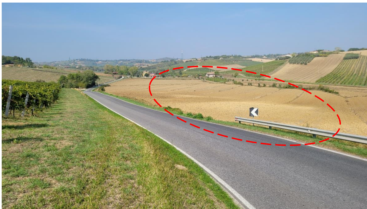
Figura 6.5 – Ripresa fotografica con evidenziata, a valle della strada, la zona interessata dai fenomeni di creep.
