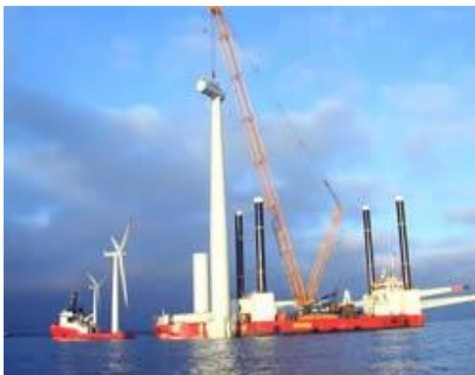
Figura 5-16 Pontone durante l'assemblaggio di una navicella
