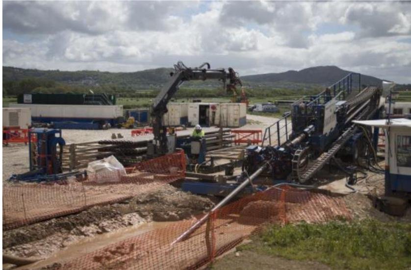
Figura 6-5 Esempio di drilling rig per la realizzazione di HDD terra-mare (Burbo Bank) .
