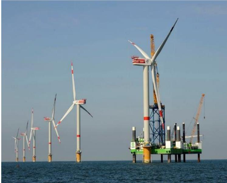
Figura 5-18 Installazione delle pale del rotore su Aerogeneratore
