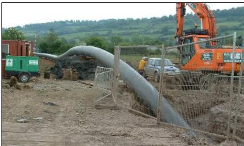
Figura 5-30 esempio di fase di perforazione e successivo inserimento di una tubazione
