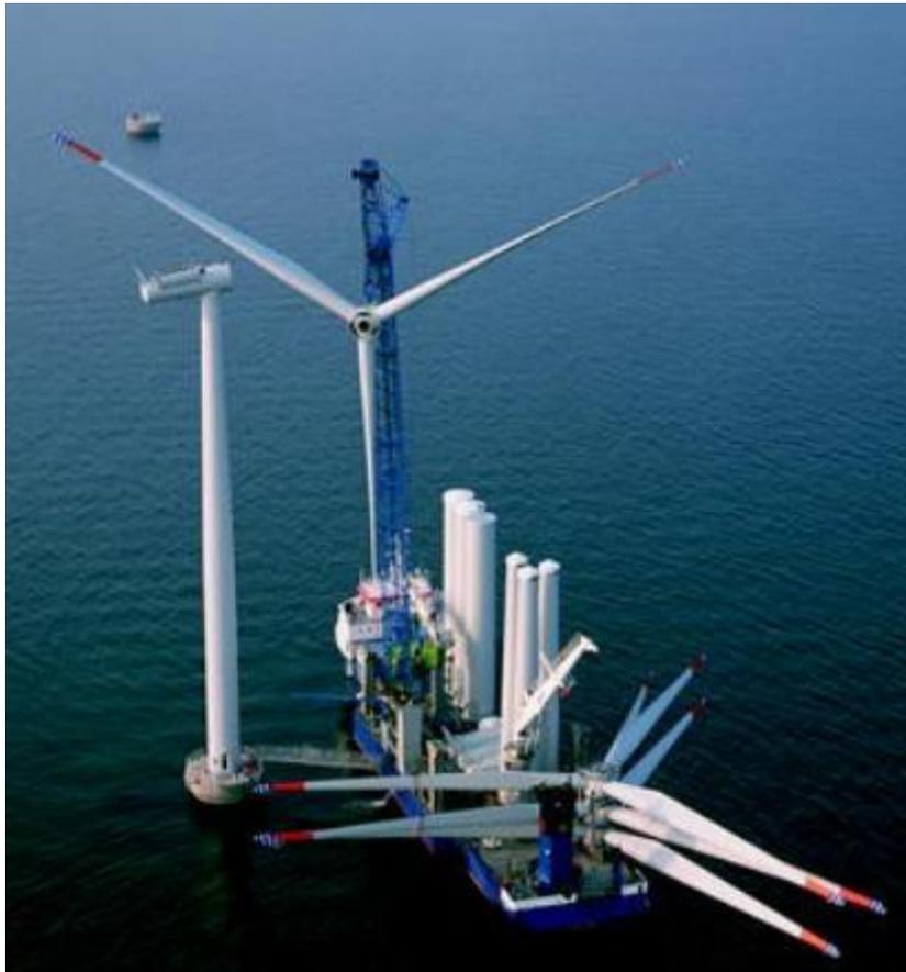
Figura 5-14 Esempio di installazione Rotor Star
