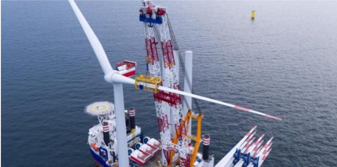
Figura 5-15 Esempio di trasporto ed installazione componenti aerogeneratori (progetto Gemini, Van Oord)
