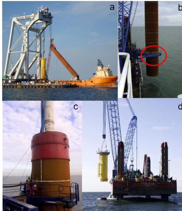
Figura 5-10 Esempio di installazione di un monopalo offshore e del tronchetto di transizione (Fonte: Seaway Heavy Lifting, Ref/a8/)
