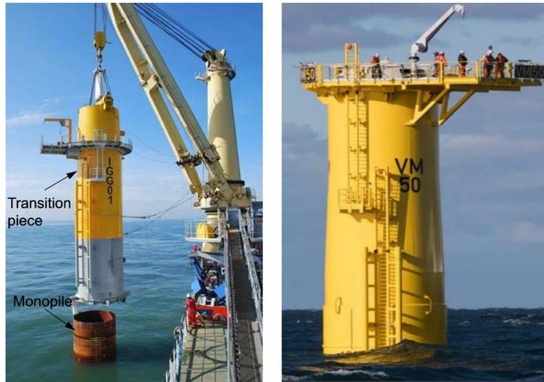
Figura 5-12 Esempio di installazione di un giunto di transizione per fondazione a monopalo (Fonte Ref. /a8/)
