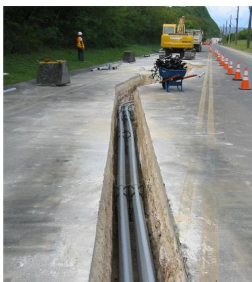
Figura 6-12 esempio di scavo per interrimento su asfalto .
