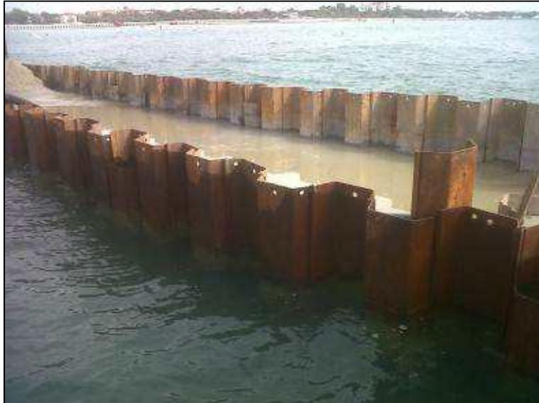
Figura 5-32 Postazione di recupero con palancole per il contenimento e il recupero dei fanghi di perforazione
