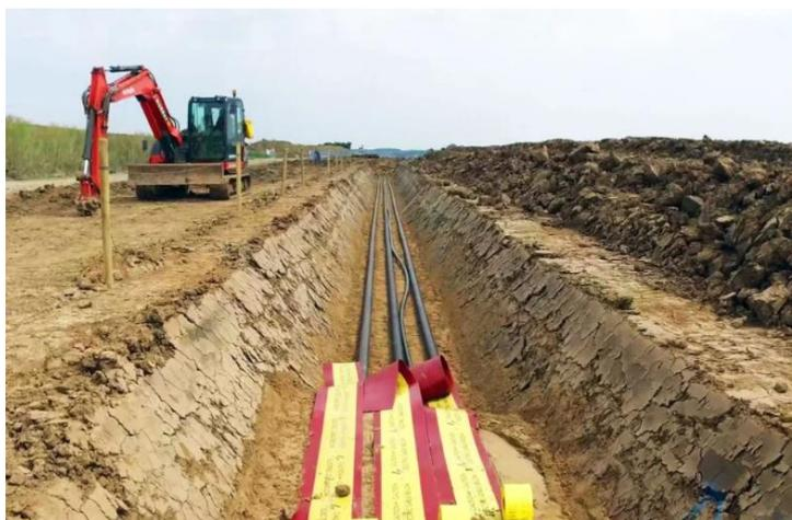
Figura 6-11 esempio di scavo per interrimento cavo (Hornsea Project One) in campagna.
