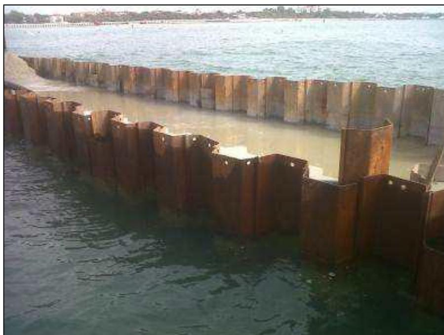
Figura 5.6 \_ Postazione di recupero con palancole per il contenimento il recupero dei fanghi di perforazione
