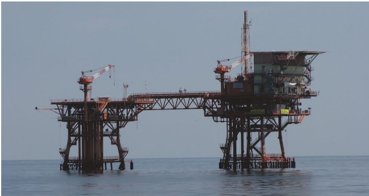
Figura 1.4 – Piattaforma Azalea B su cui è stato installato l’anemometro LIDAR
