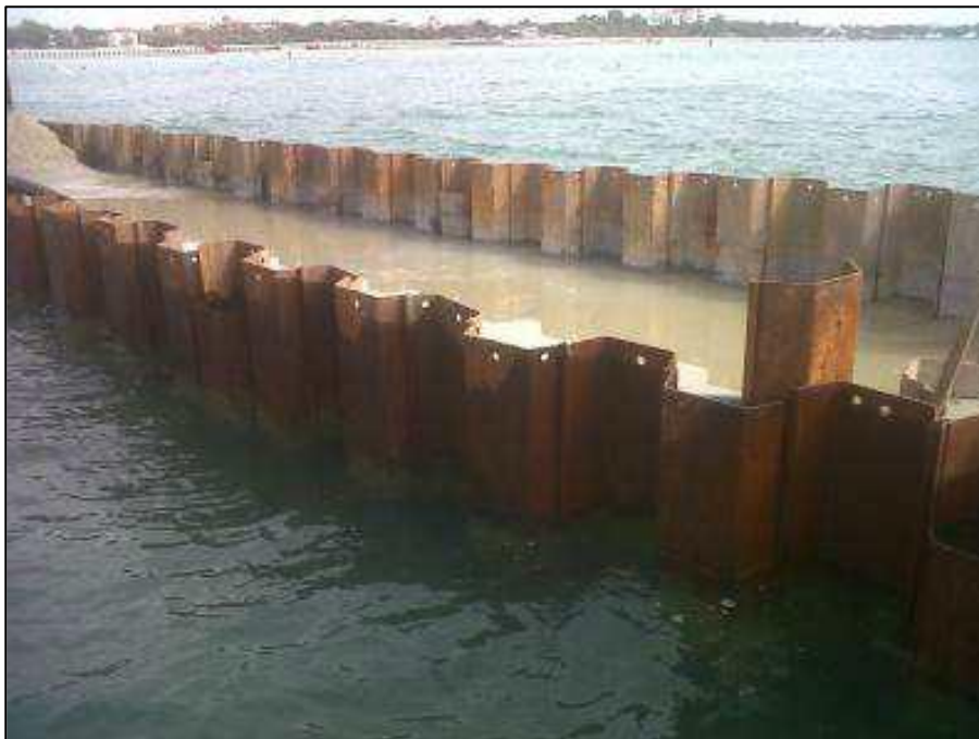
Figura 5.15 _ Postazione di recupero con palancole per il contenimento il recupero dei fanghi di perforazione
