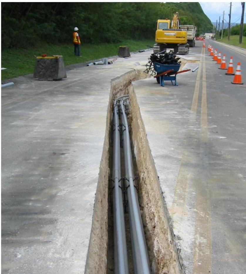
Figura 6.32 \_ Esempio di scavo per interrimento su asfalto .
