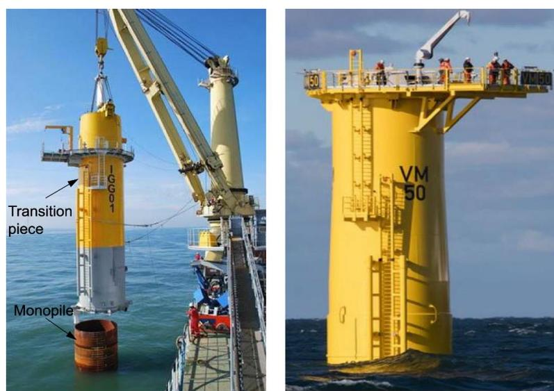
Figura 6.11 \_ Esempio di installazione di un giunto di transizione per fondazione a monopalo
