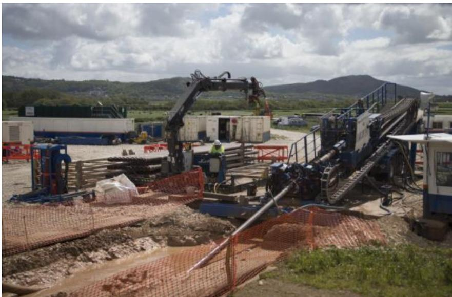
Figura 6.29 \_ Esempio di drilling rig per la realizzazione di HDD terra-mare (Burbo Bank) .
