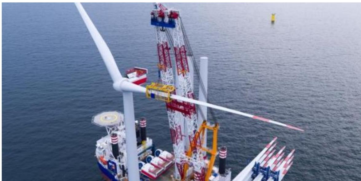
Figura 6.13 \_ Esempio di trasporto ed installazione componenti aerogeneratori (progetto Gemini, Van Oord)
