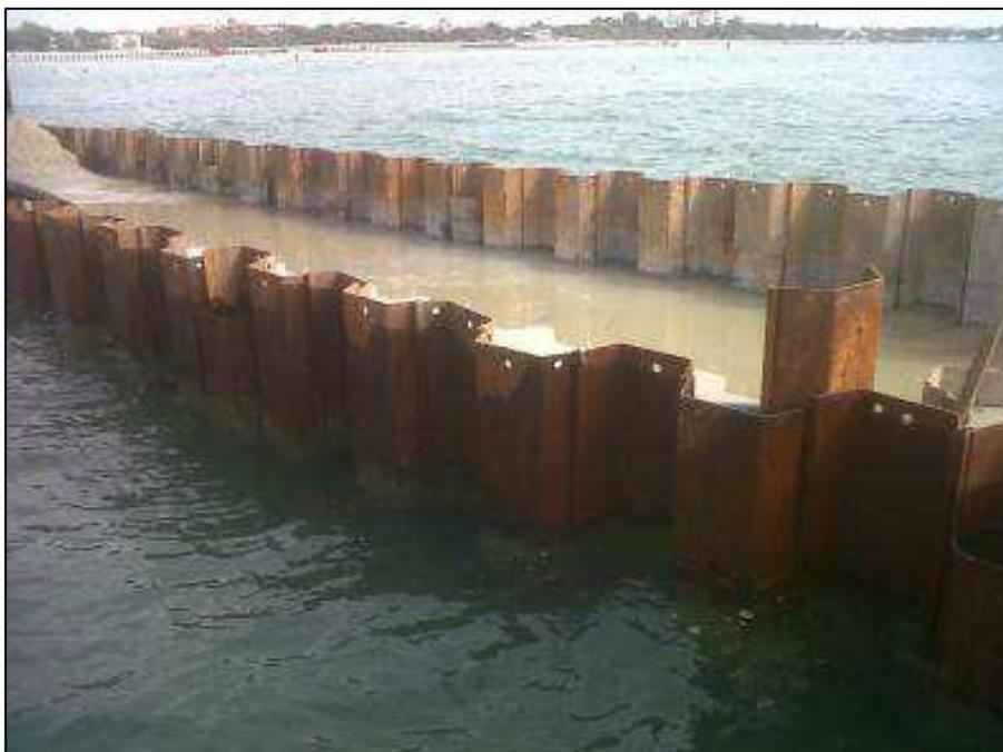
Figura 6.25 \_ Postazione di recupero con palancole per il contenimento il recupero dei fanghi di perforazione
