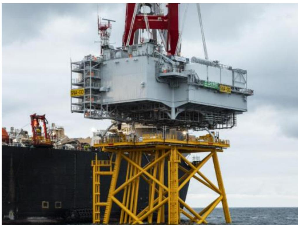
Figura 6.19 \_ Installazione Topside
