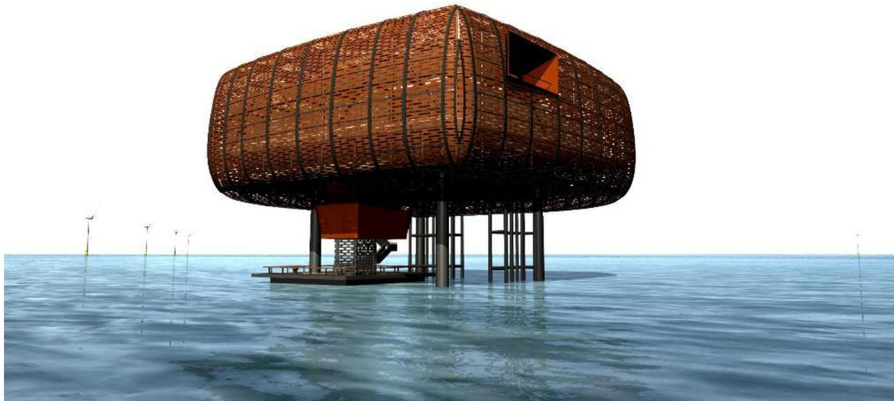
La stazione di trasformazione elettrica marina raccoglie i cavi provenienti dai vari sottocampi alla tensione di 66 kV e dopo la trasformazione del voltaggio a 380 kV invia l'energia ai cavi di collegamento con la costa, secondo lo schema unifilare riportato negli elaborati OWFRMN\_V2-SC4-03-1-2\_D-UNIFILARE\_LAY-A e LAY-B.
