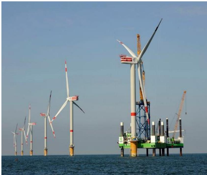
Figura 6.16 \_ Installazione pale del rotore su Aerogeneratore
