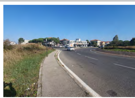
Rotonda fra Via Varisco e Via Flaminia, vista NW.
