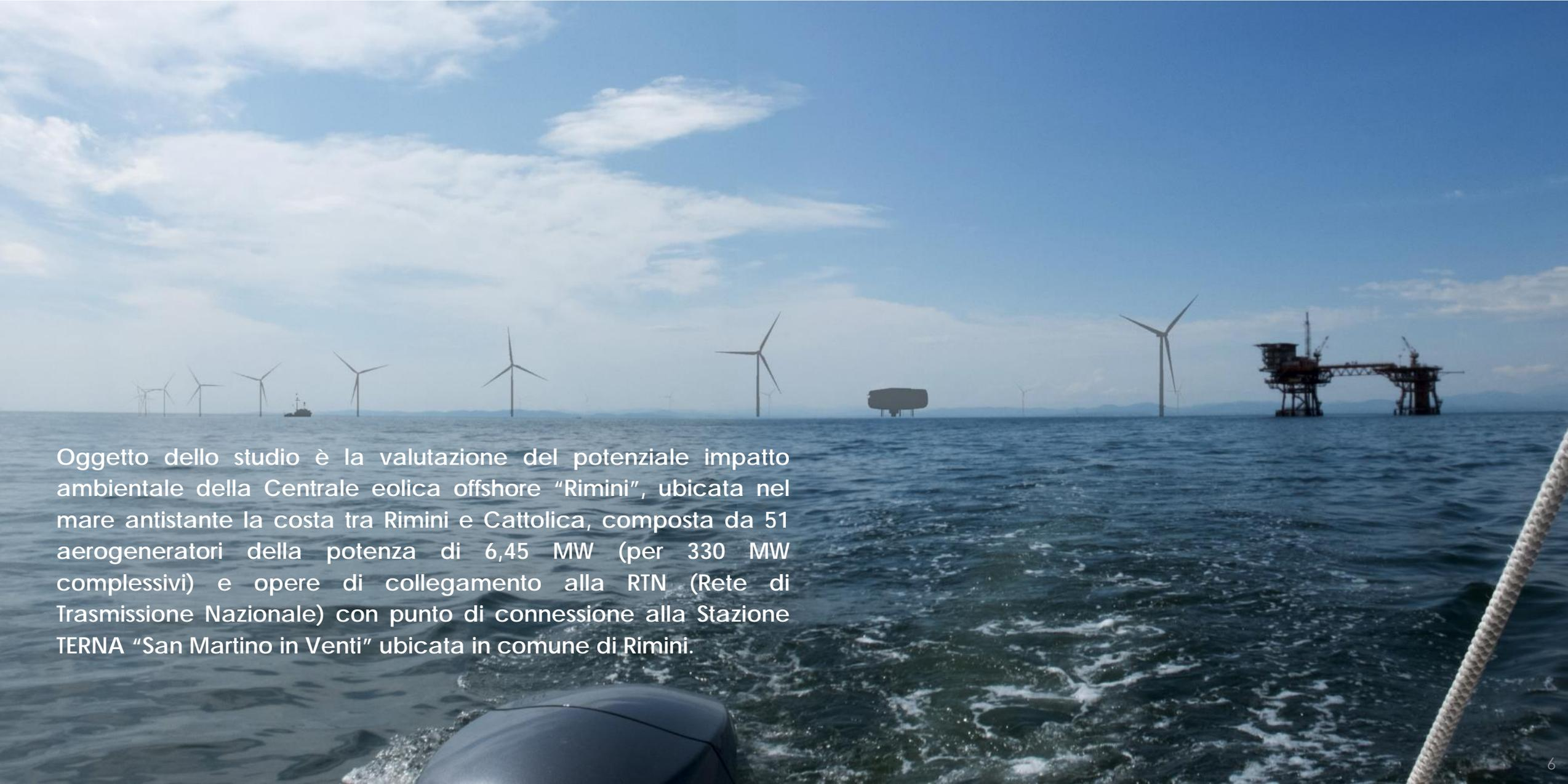
Oggetto dello studio è la valutazione del potenziale impatto ambientale della Centrale eolica offshore "Rimini", ubicata nel mare antistante la costa tra Rimini e Cattolica, composta da 51 aerogeneratori della potenza di 6,45 MW (per 330 MW complessivi) e opere di collegamento alla RTN (Rete di Trasmissione Nazionale) con punto di connessione alla Stazione TERNA "San Martino in Venti" ubicata in comune di Rimini.
