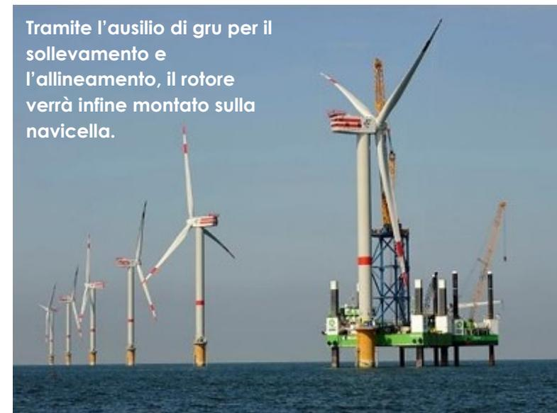
Tramite l'ausilio di gru per il sollevamento e l'allineamento, il rotore verrà infine montato sulla navicella.
