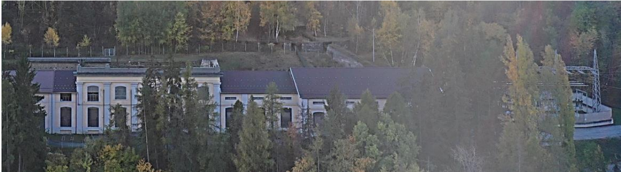
Fig. 1.4: Centrale esistente in località Chavonne (sopralluogo 2021)
