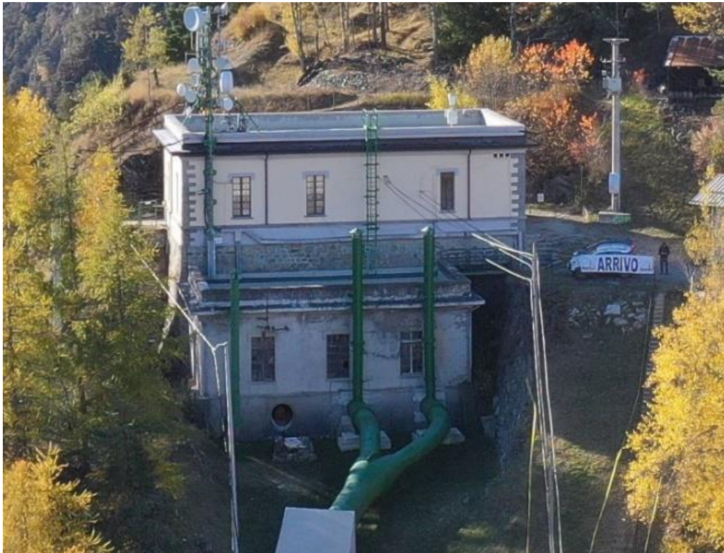
Fig. 1.3: Vasca di carico (sopralluogo SP 2021)
