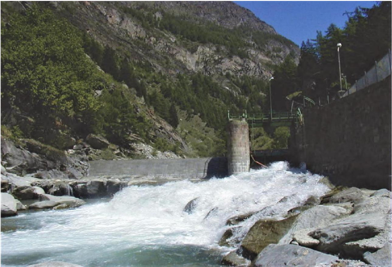
Fig. 1.1 : Opera di presa di La Nouva
