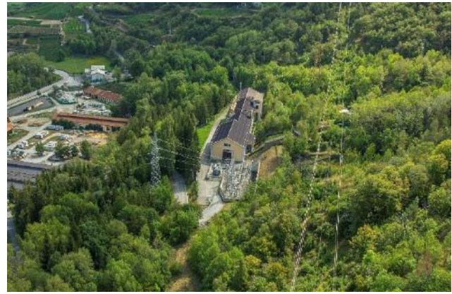
Fig. 3.18: In sinistra tratta L175 132 kV in partenza dalla stazione di Chavonne e in destra linea AT L209 220KV
