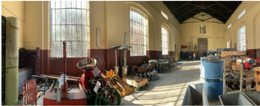
Fig. 3.21: Vista stabile di centrale esistente lato magazzino (lato scarico centrale)
