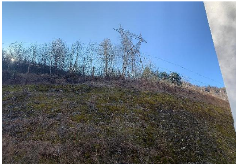
Fig. 3.19: Transito della linea L209 lungo il retro dello stabile di centrale (lato monte)
