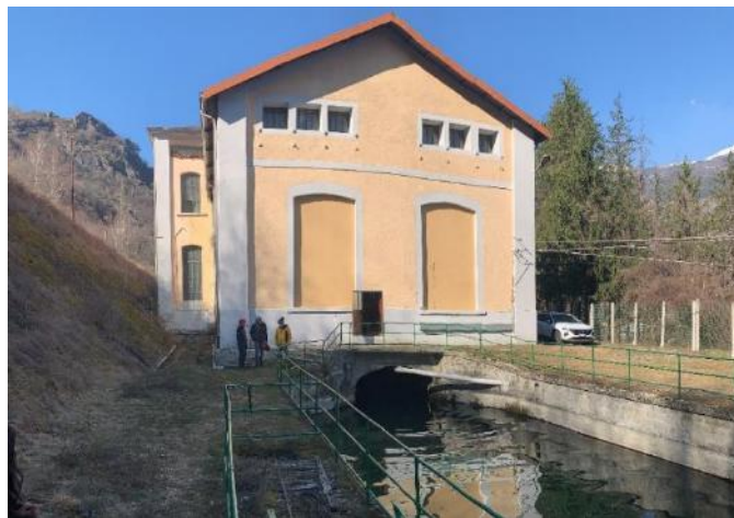
Fig. 3.22: Vista stabile di centrale esistente lato magazzino (lato scarico centrale)
