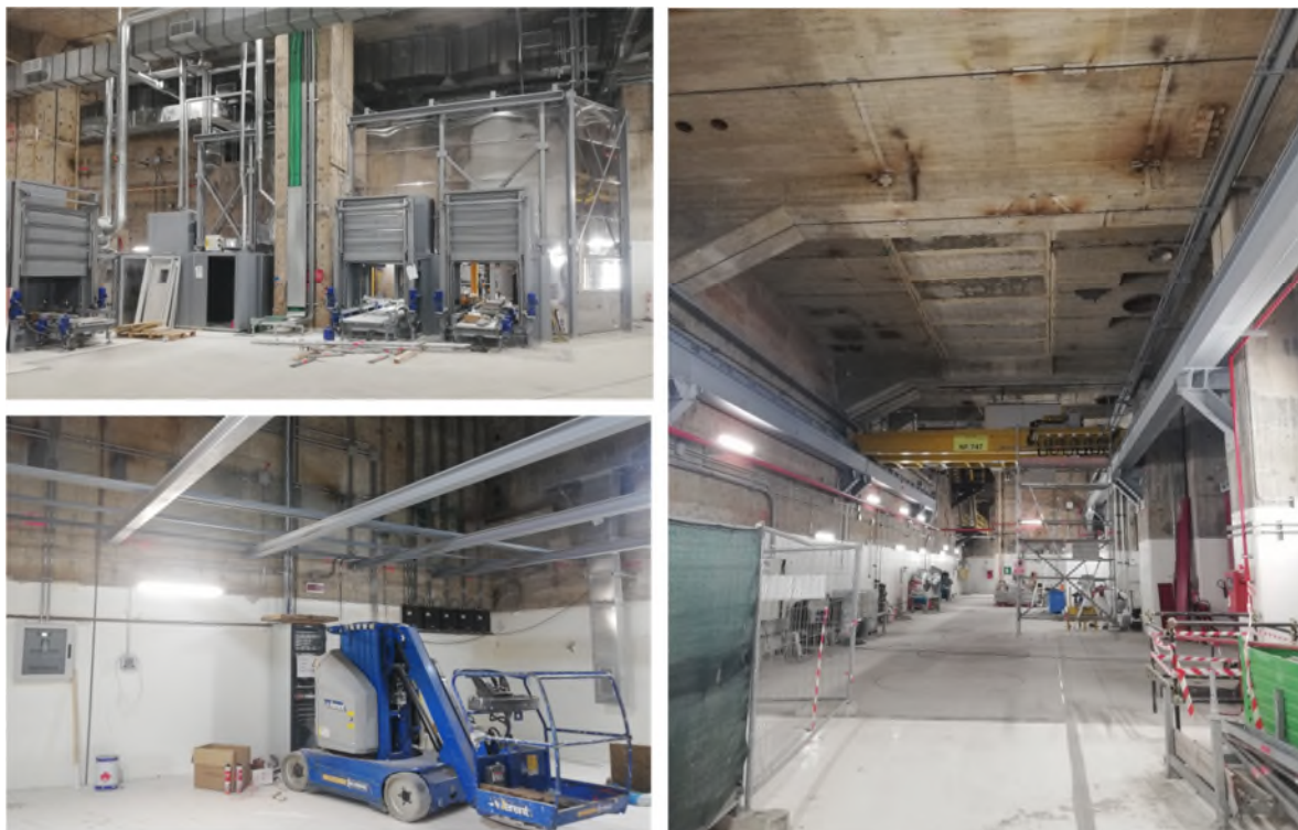
Installazione sistemi e impianti in Edificio Turbina
