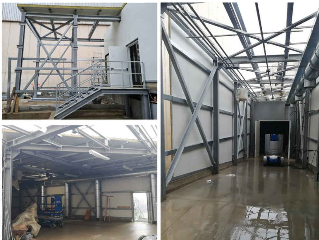
Attività di realizzazione della Waste - Route
