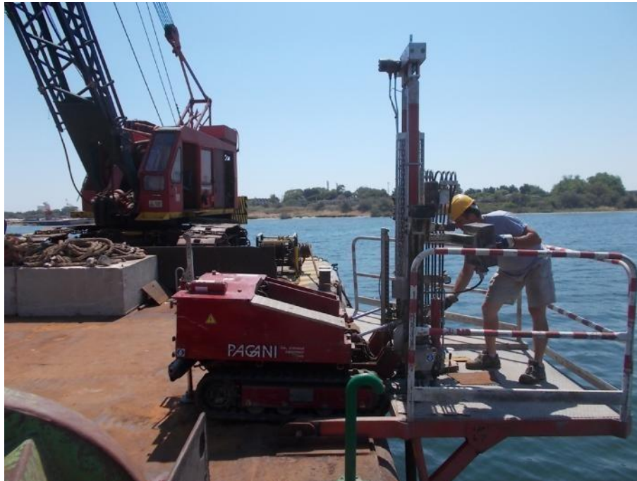
Foto 25: Prova Penetrometrica CPTU2 - Postazione
