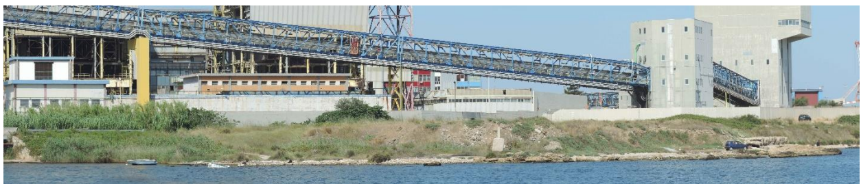
Zona a ponente dell'insenatura – Zona W2– Foto E
