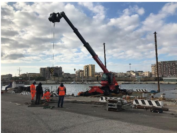
Foto 4: Assemblaggio vibrocarotiere
