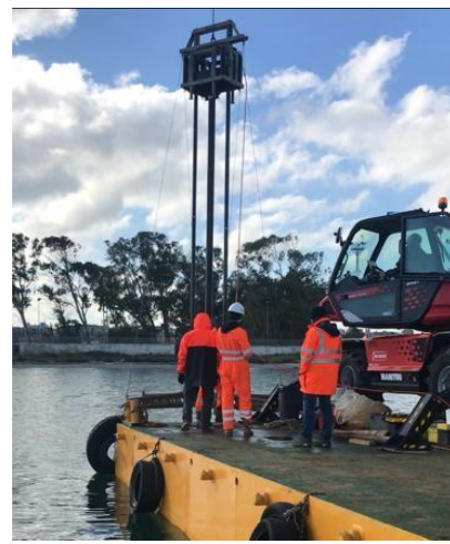
Foto 11: Sondaggio a mare vibrocarotiere
