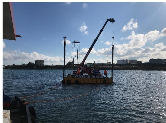
Foto 5: Movimentazione vibrocarotiere
