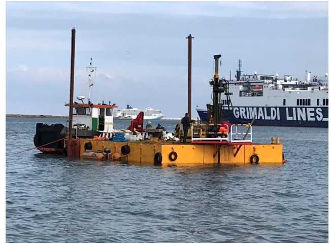
Foto 9: Sondaggio a mare carotiere a rotazione
