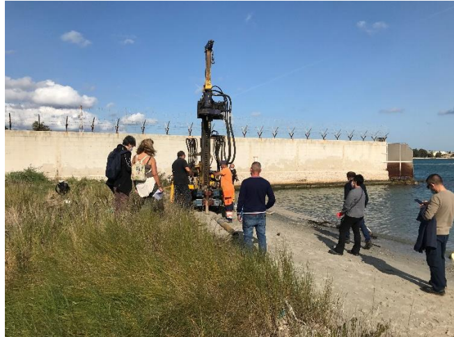
Foto 7: Sondaggio su arenile
