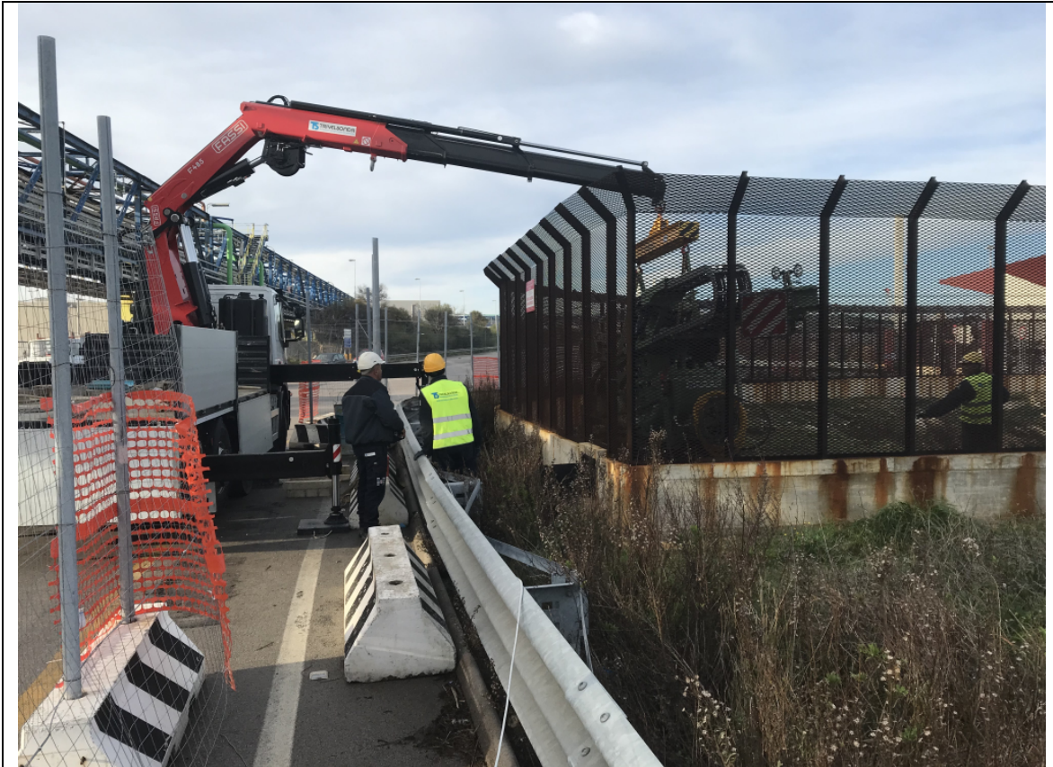
Fig. 9.2 – Posizionamento della macchina di perforazione.
