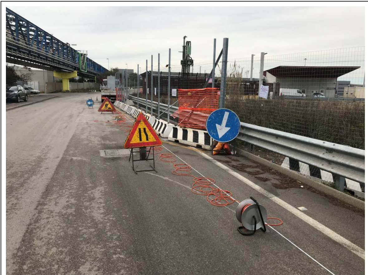
Fig. 10.1 – Fase di esecuzione dell'indagine sismica.
