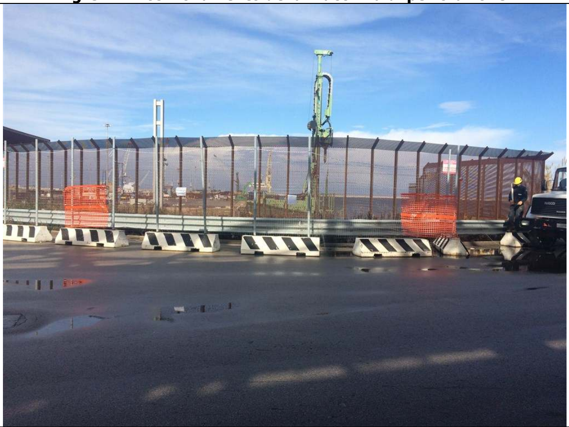
Fig. 9.3 – Fase di esecuzione dei sondaggi.
