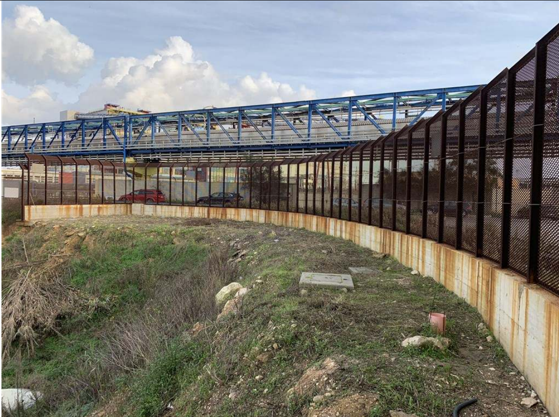
Fig. 2.3 – Particolare della scarpata e della recinzione.
