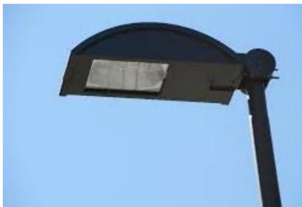
*Figura 4.39: Esempio di apparecchio completamente schermato "full-cut-off"*
