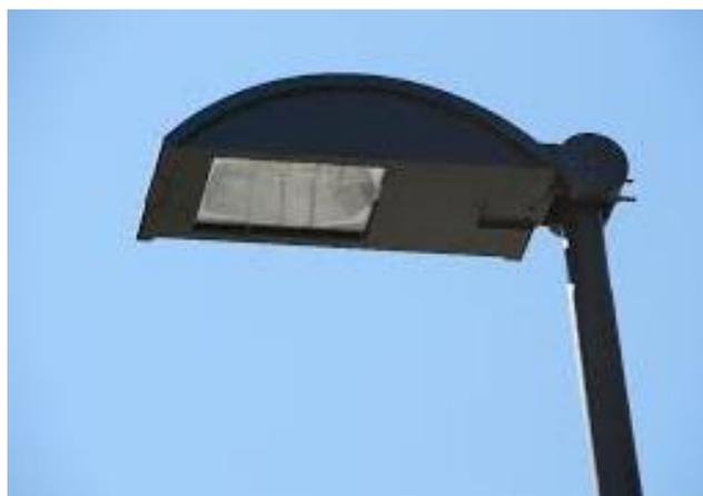
Figura 4.36: Esempio di apparecchio completamente schermato (full-cut-off).
