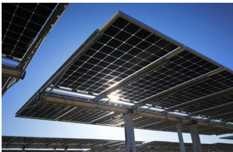
Figura 2.49 Esempio di struttura a tracker monoassiale
