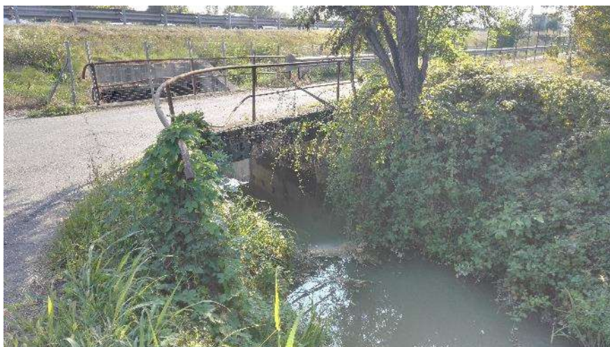
Figura 5-13. Ponticello a valle dell'attraversamento autostradale
