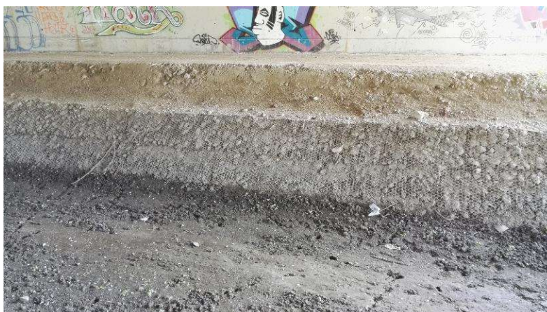
Figura 5-26. Sistemazione spondale esistente in corrispondenza dell'impalcato
