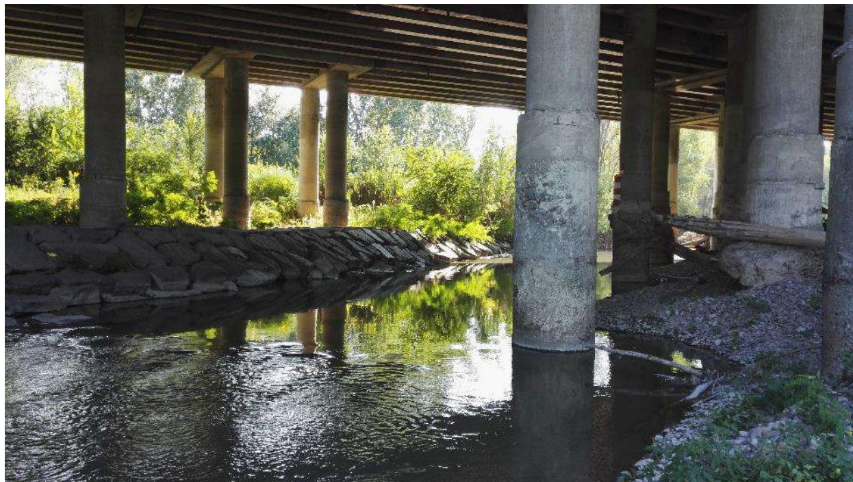
Figura 6-42. Scogliera in massi attualmente presente in corrispondenza dell'impalcato
