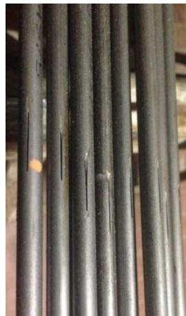
Figura 3.3.2: Iniezioni con resine: tubicini di iniezione
