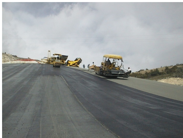
Figura 7.4.4: Diga di Arcichiaro, strato imp., compattazione
