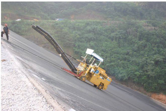
Figura 7.4.1: Diga di Bumbuna (Sierra Leone), Fresatura delle strato superiore impemeabile
