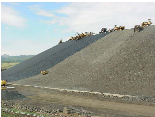
Figura 7.4.3: Diga di Gigel Gibe, Schema di stesa
