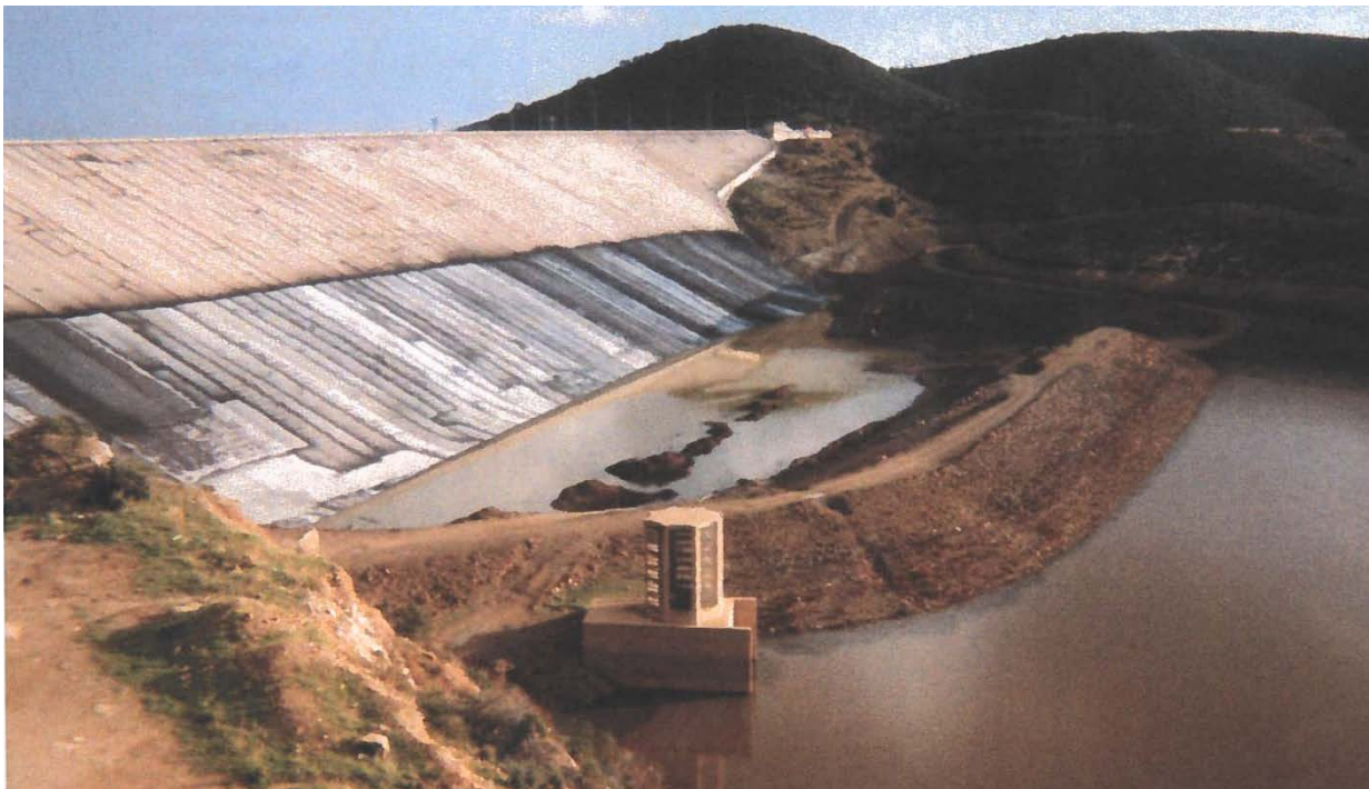
Figura 5.1.1: Avandiga (durante la costruzione)
