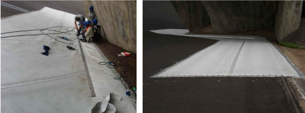
Figura 7.4.5: Diga di Bumbuna, Protezione Giunto Conglomerato-Calcestruzzo
