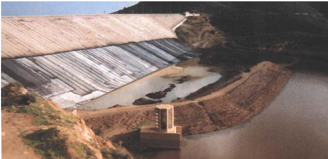
Figura 4.2.2: Avandiga durante la fase di costruzione
