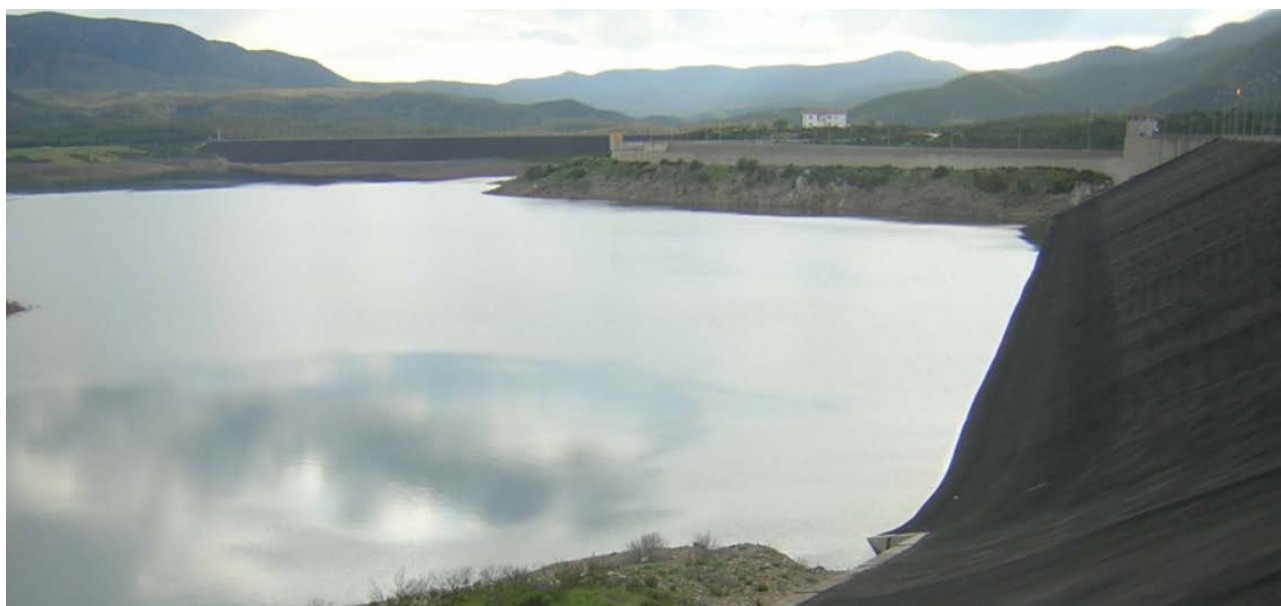
Figura 2.1.1: Bacino Medau Zirimilis con in primo piano il paramento di monte della diga principale
