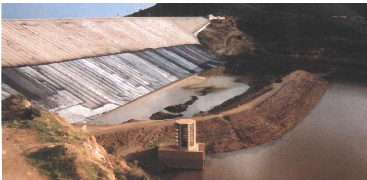
Figura 3.2.2: Avandiga durante la fase di costruzione
