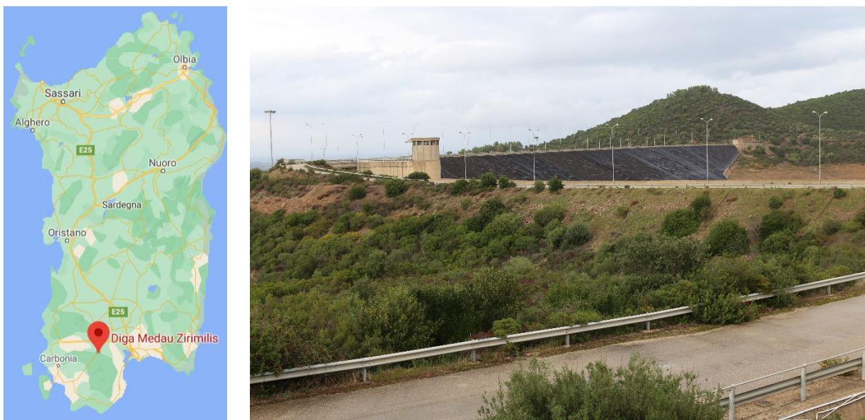
Figura 2.1.1: Localizzazione e ripresa fotografica dell'area interessata dagli interventi oggetto del presente Studio
